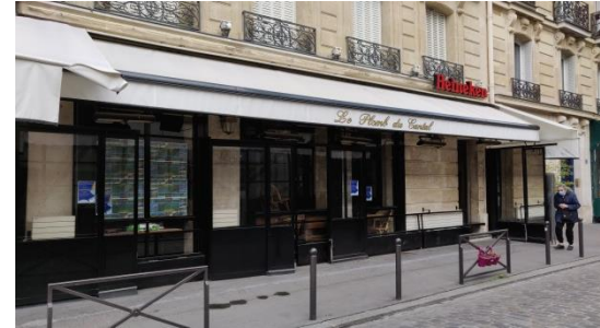
Restaurant – rue de la Gaité
