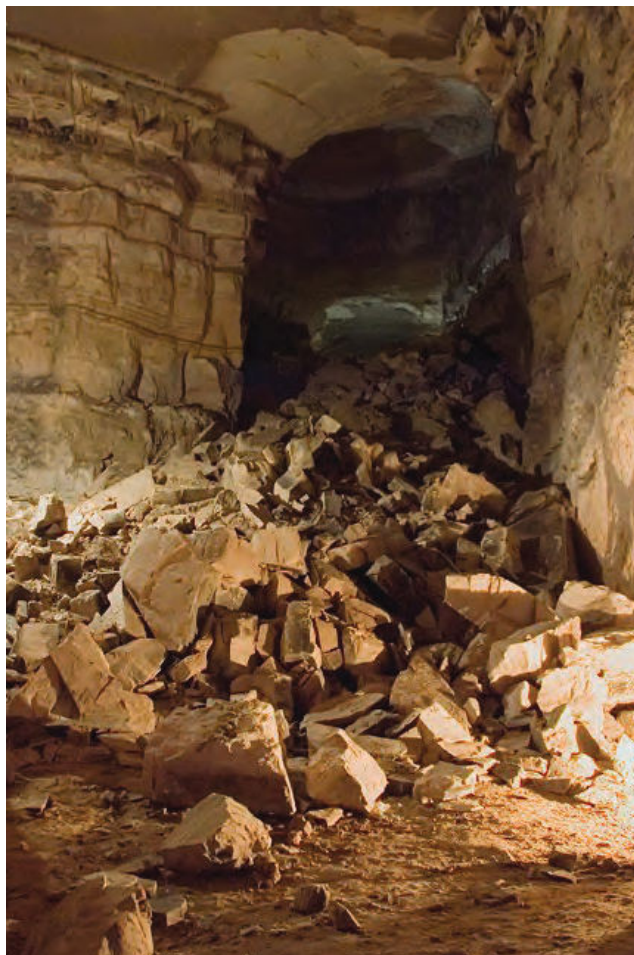
Exemple de fontis venu à jour au droit d'une carrière de gypse
