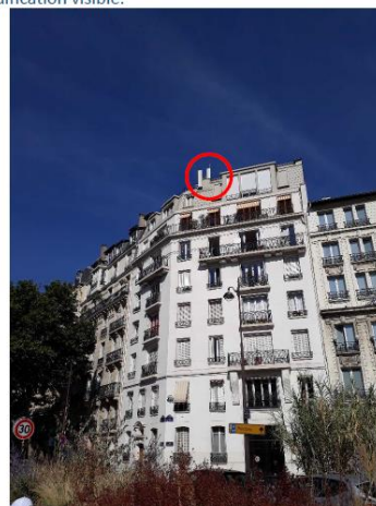
Etat projeté : Pas de modification visible.
