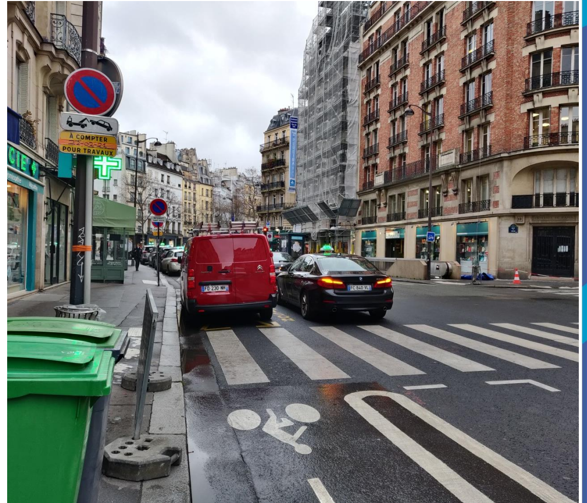
Restant à faire – tronçon entre la rue Mabilion et le boulevard Saint-Germain
