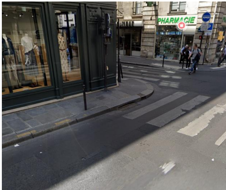
Bouche d'égout empêchant l'abaissement de bordure
