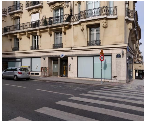
Poste – rue de Vaugirard
