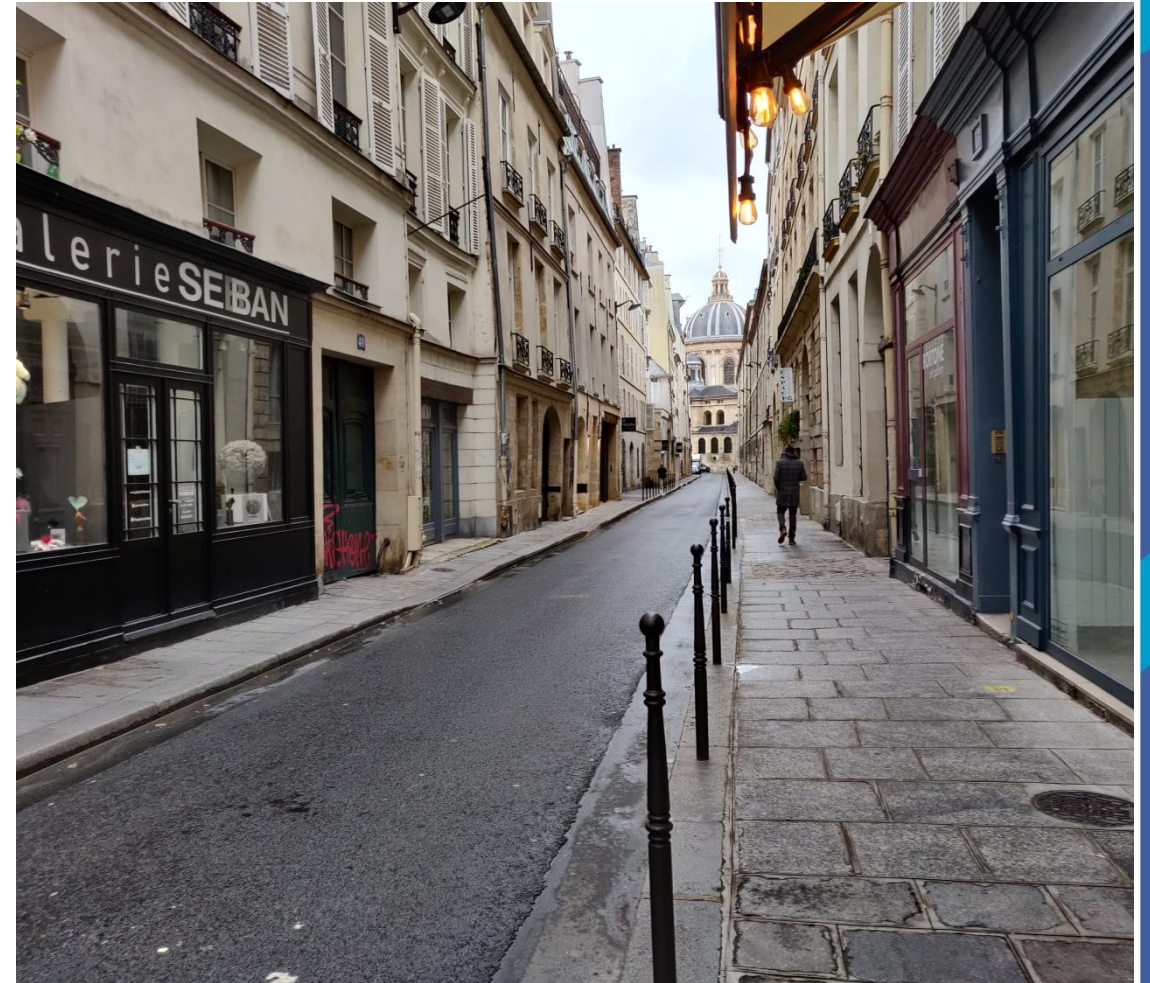
Rue Mazarine - suppression d'une bande de stationnement et élargissement de trottoir
