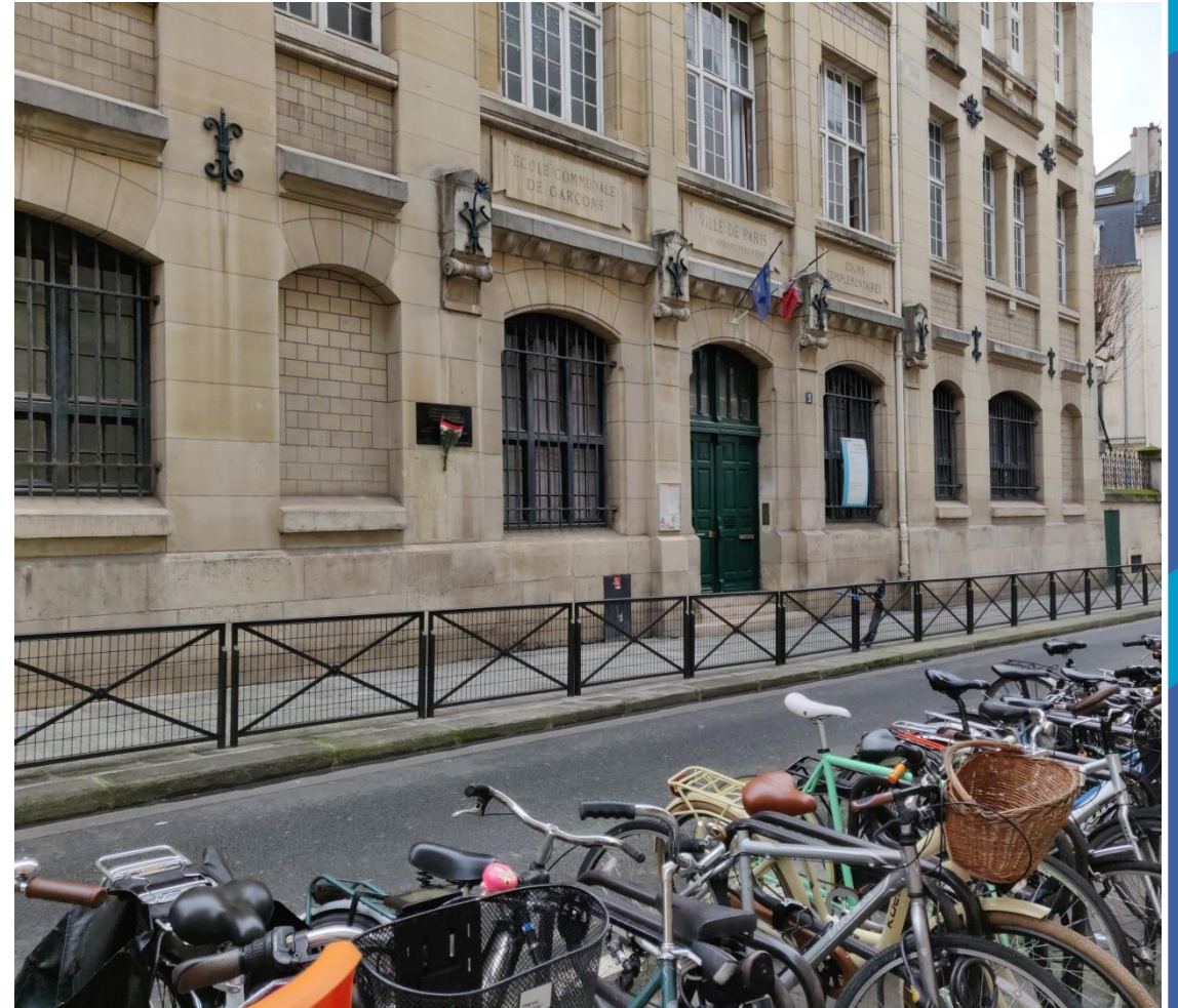
SEGPA du collège Jacques Prévert – rue du Pont de Lodi
