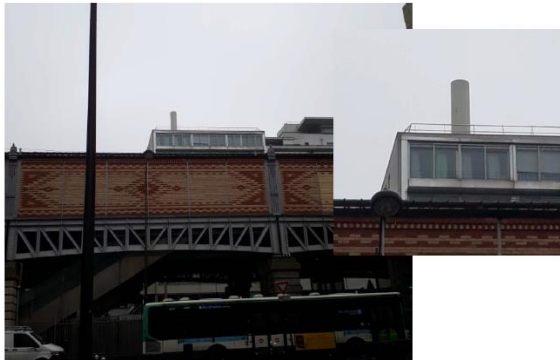
Etat de l'existant : Antennes existantes dans Fausse Cheminée
