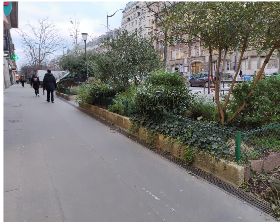
Reprise du trottoir et du caniveau à grille – boulevard Saint-Marcel
