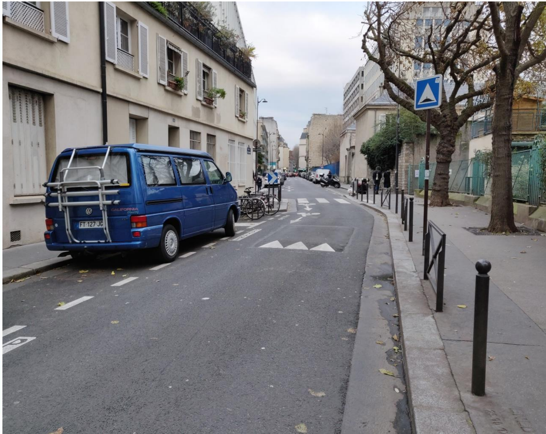
Pose de ralentisseurs - rue du fer à Moulin
