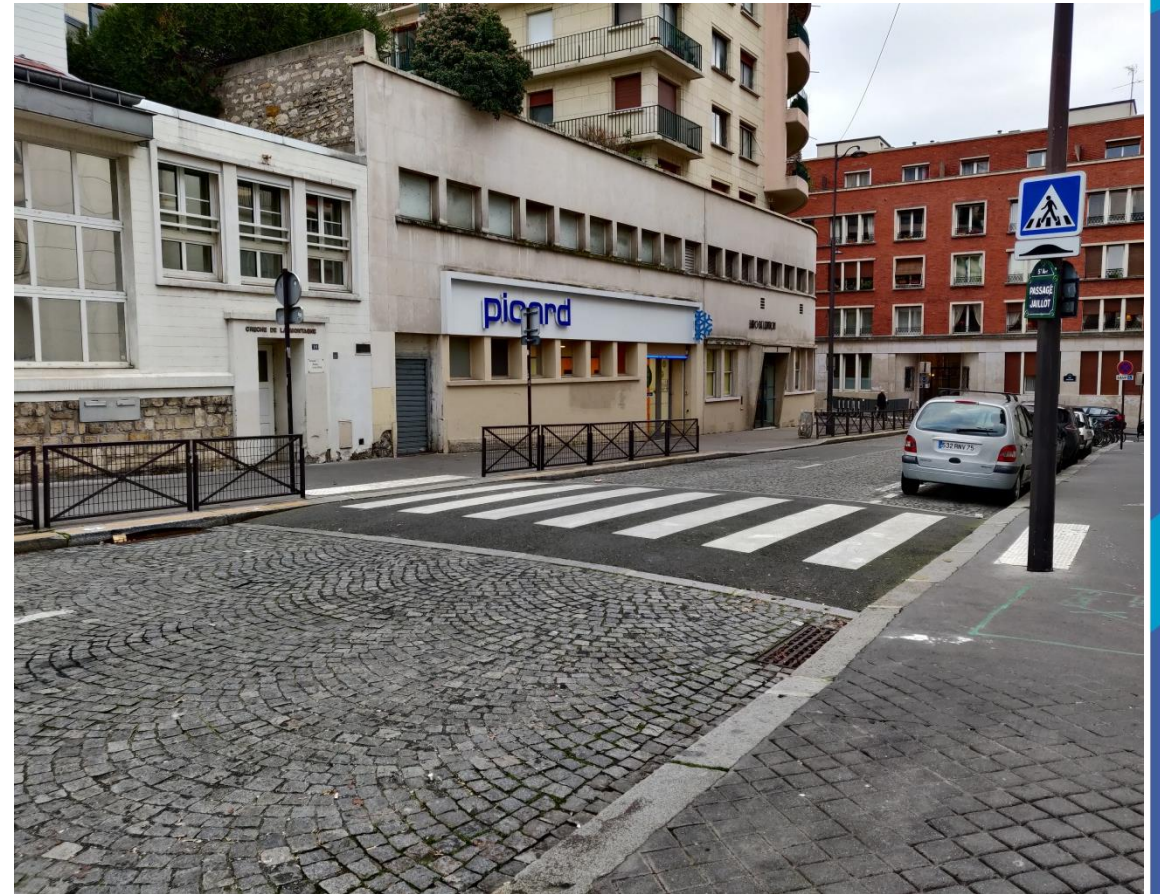
Amélioration des traversées piétonnes – rue Saint-Médard
