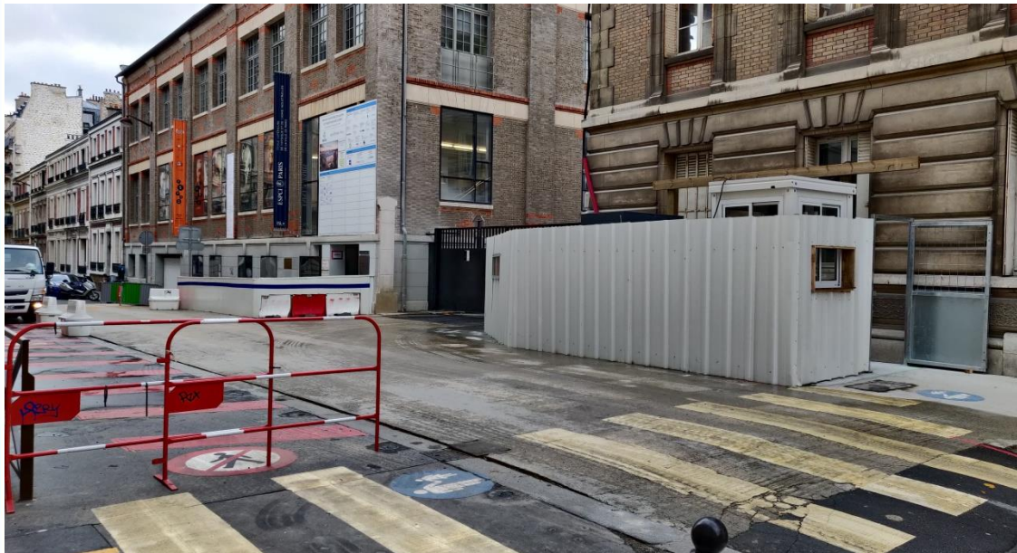
Dalle de répartition en béton – accès à l'ESPCI – rue Vauquelin
