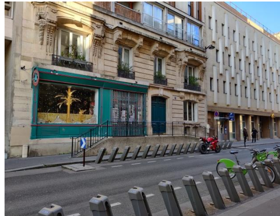
Rue de l'Épée de Bois - Porte d'immeuble surélevée
