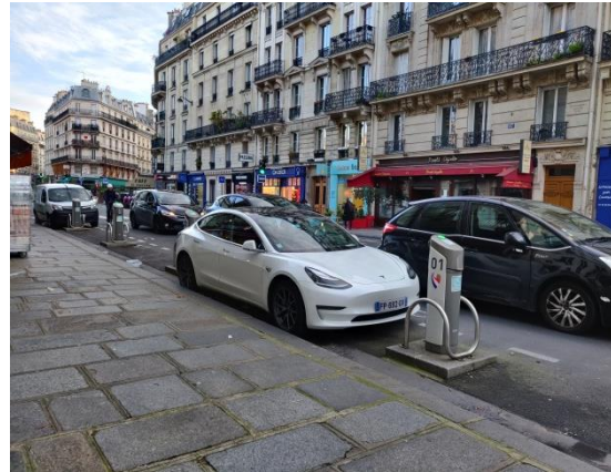
Borne de recharge – rue Monge
