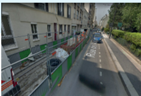
Emprises de chantier
