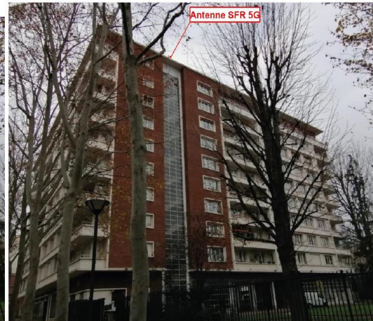
Photo du site vue depuis la rue après travaux
