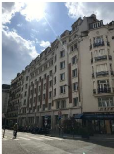
L'installation technique n'est pas visible depuis ce point de vue
