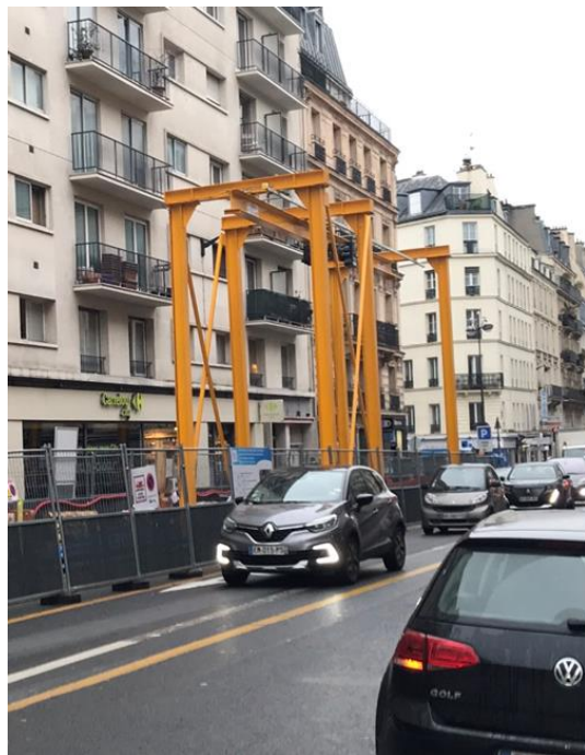
Travaux des concessionnaires en 2021
