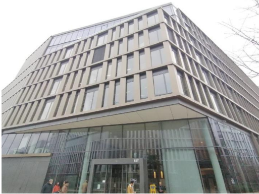
Photo du site vue depuis la rue avant travaux
