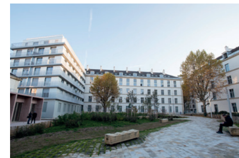
Reconversion de la caserne de Reuilly
