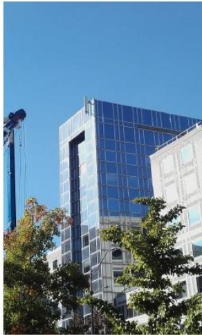
État de l'existant :
