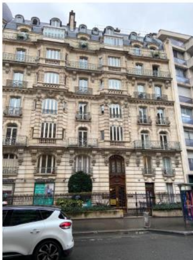
Photo du site vue depuis la rue après travaux
