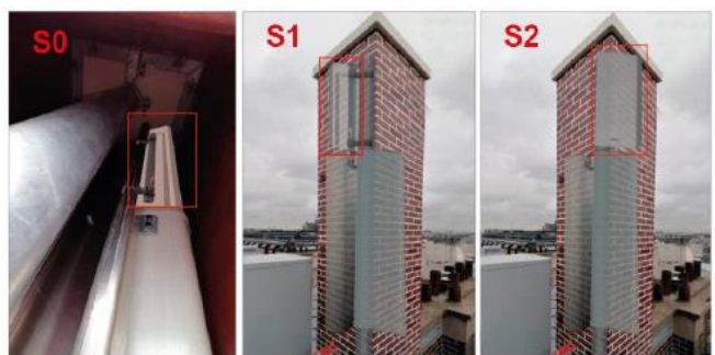
Photos des antennes après travaux
