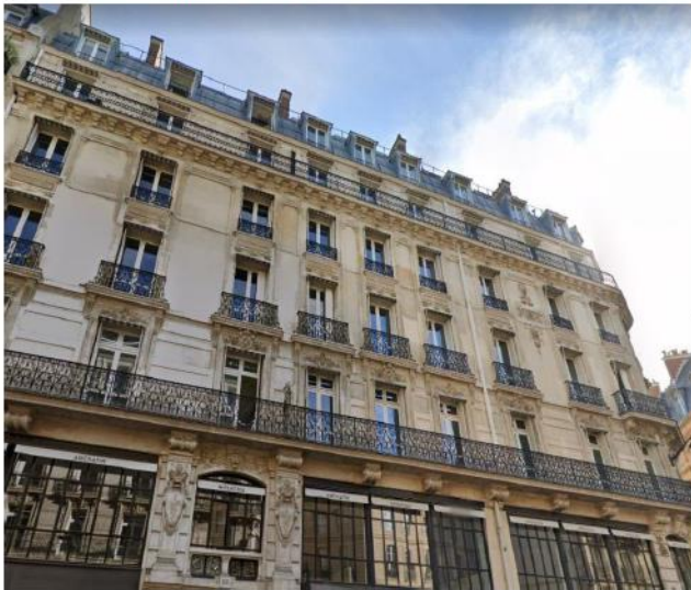
Photo du site vue depuis la rue avant travaux
