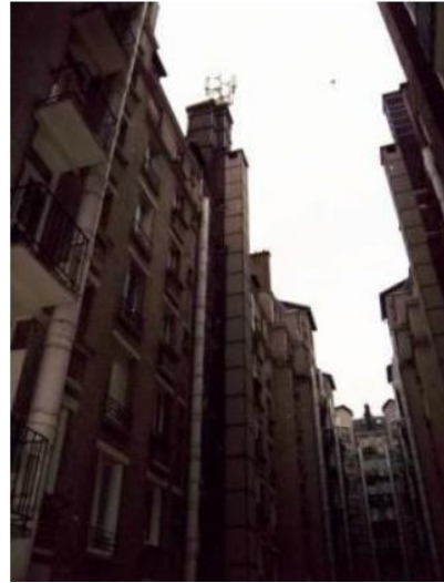
Etat projeté : Pas de modification visuelle
