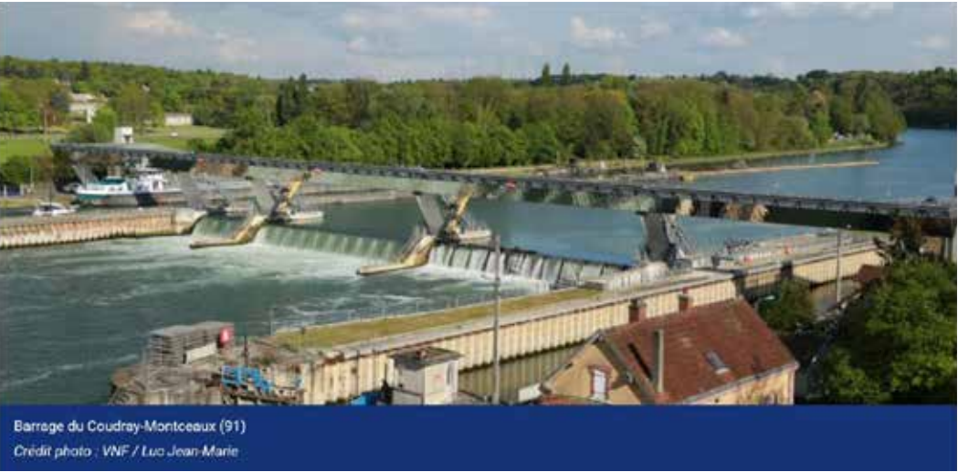
Illustration n°14 – Barrage du Coudray-Montceaux – Source VNF
