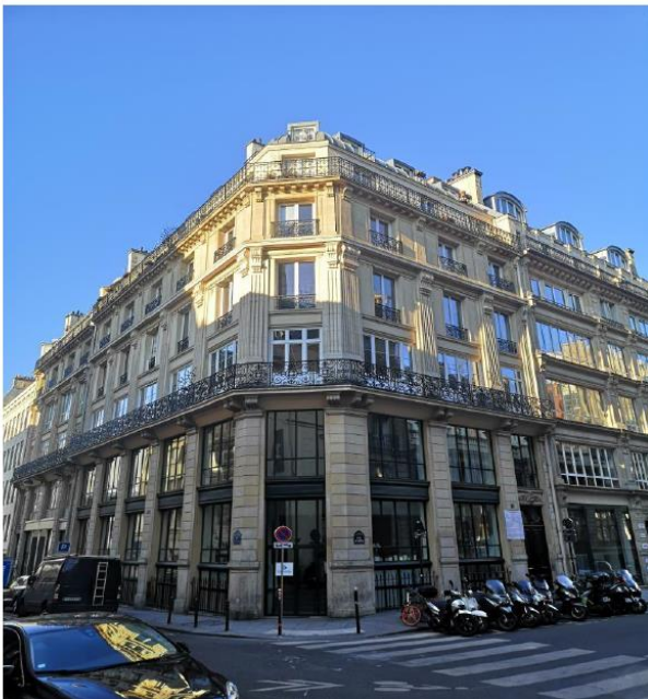
Photo du site vue depuis la rue avant travaux
