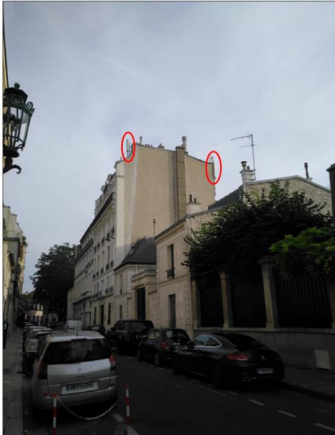
Etat projeté : Pas de modification visuelle
