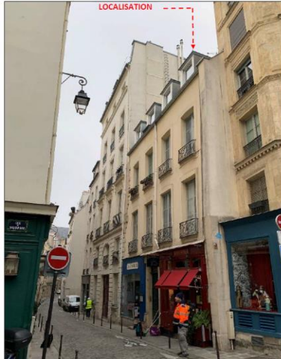
Antennes invisibles depuis rue de Vaugirard
