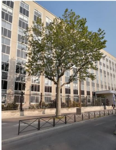
Photo du site vue depuis la rue avant travaux
