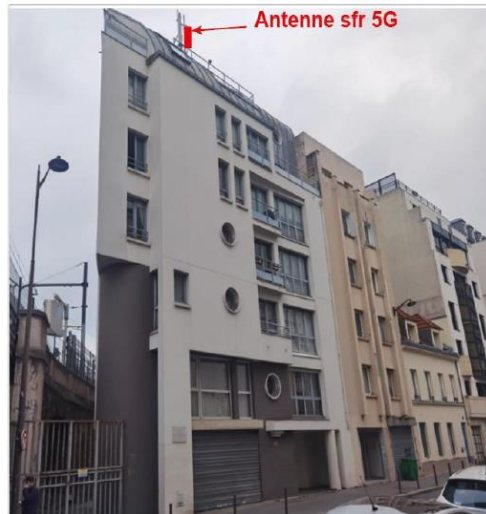
Photo du site vue depuis la rue après travaux
