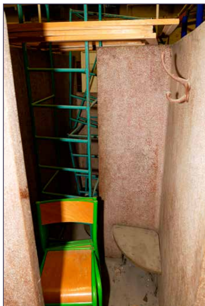
Détail d'une cabine de douche avec patère métallique.
