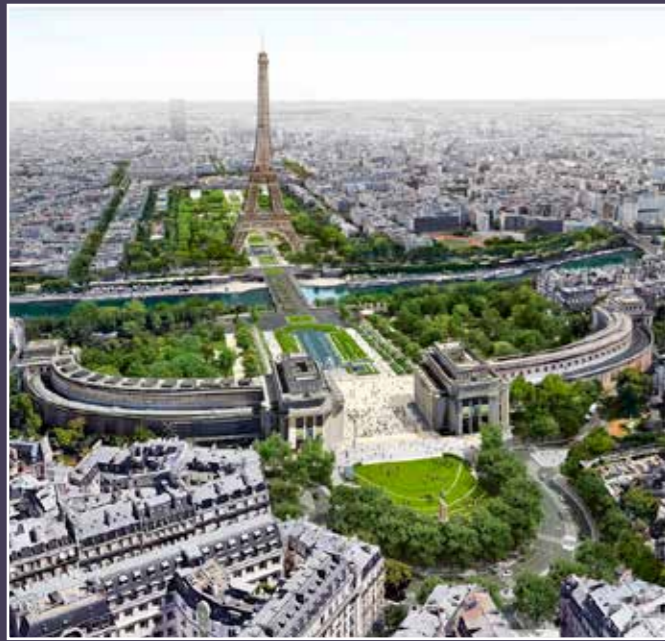
Vue globale du site après travaux (© Documentation OnEi).
