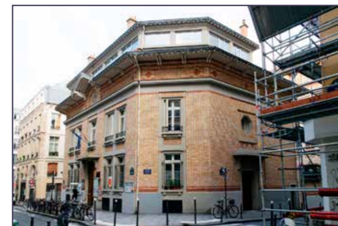
Vue de l'école depuis la rue Beauregard.
