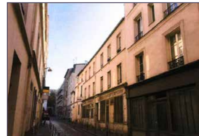
Vue actuelle depuis le passage Courtois (© Dubernet architectes).
