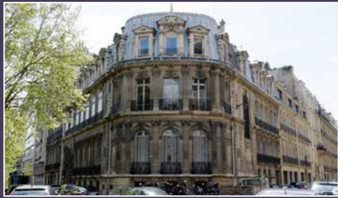
Vue depuis l'angle des deux voies (2012).
