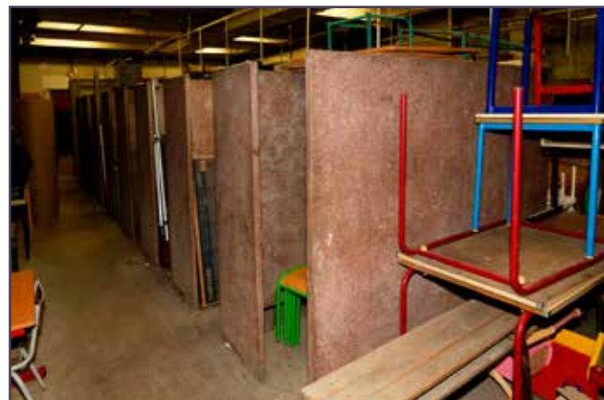
Vue générale de la salle des douches.
