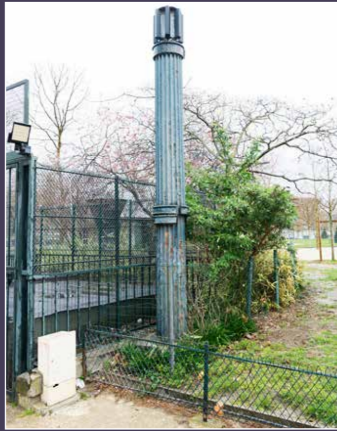
Vue actuelle de l'entrée du central téléphonique aussi dit bunker.
