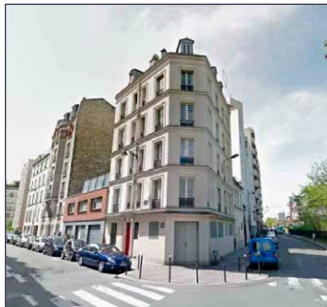
Vue actuelle du bâtiment (© & Givry).
