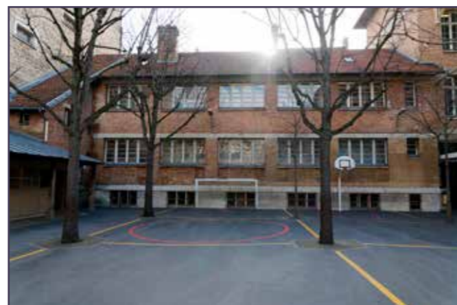
Façade sur cour du bâtiment sous lequel se situent les douches scolaires.
