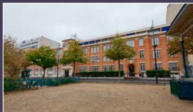
Vue actuelle du bâtiment depuis le boulevard.
