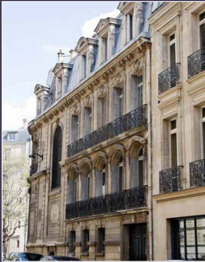
Vue de la façade sur la rue Galilée (2012).
