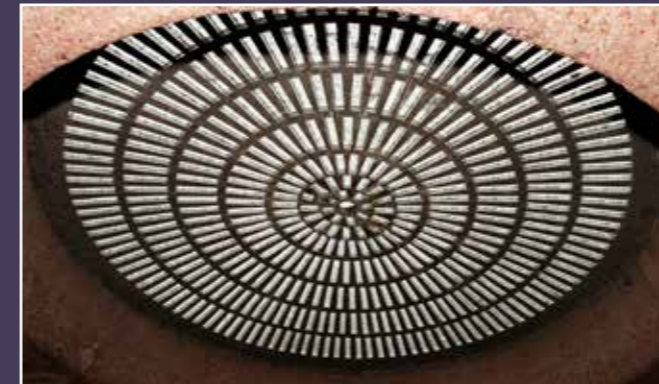
Vue de l'une des voûtes en pavés de verre des tunnels.
