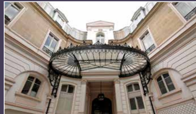
Vue de la marquise qui orne la cour (2007).
