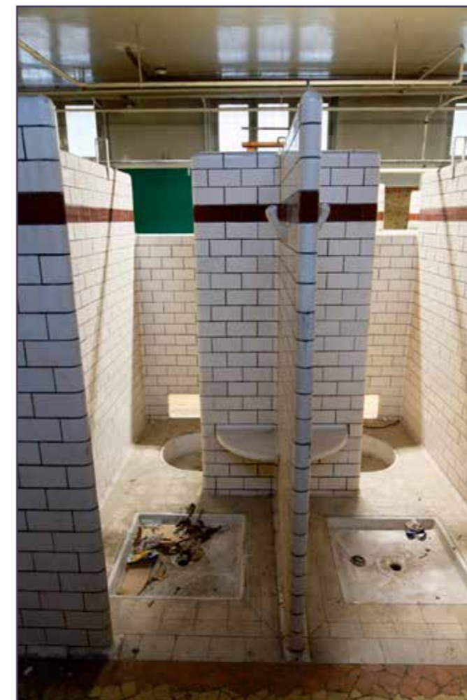
Deux cabines de douches.
