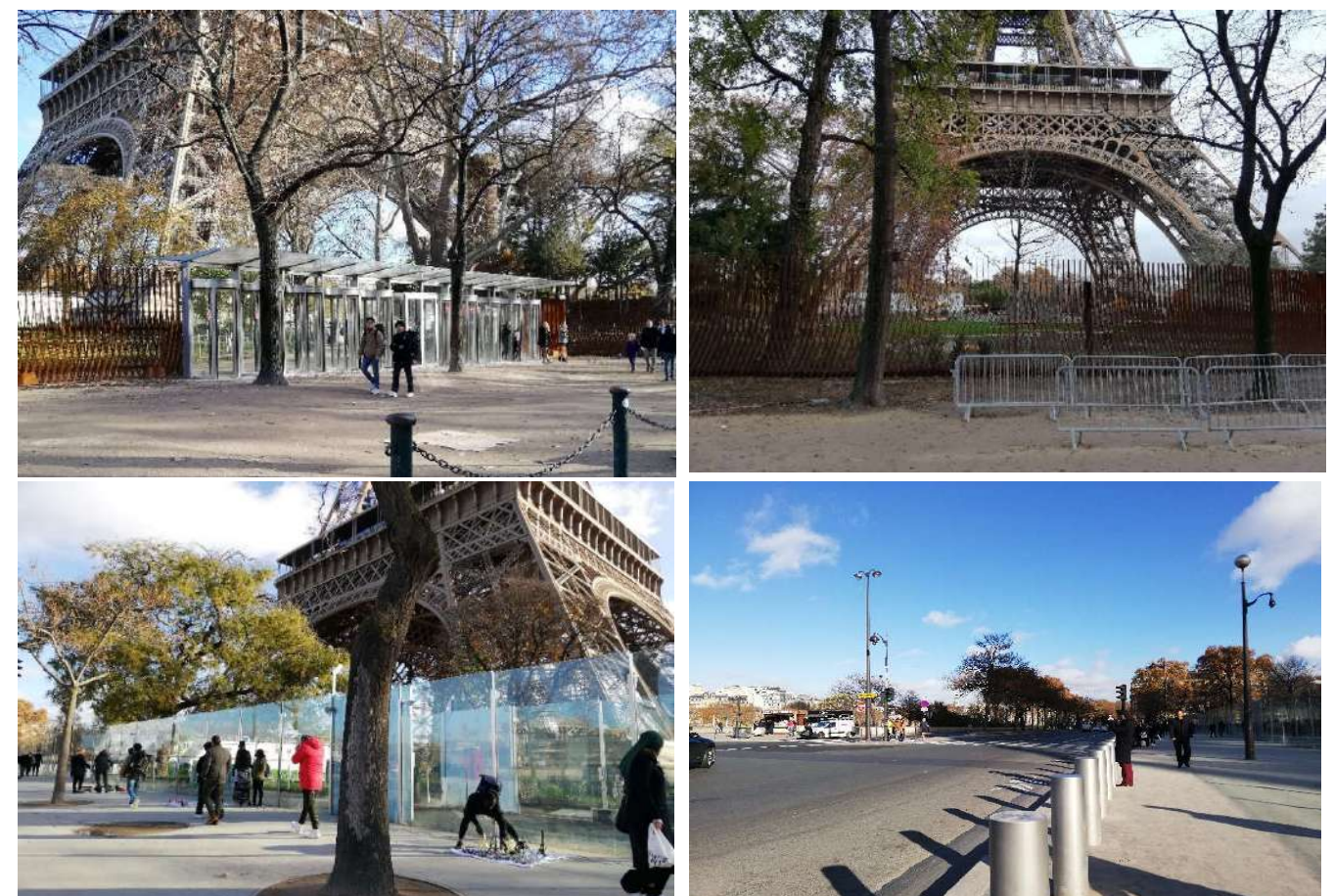
Figure 69 : Enceinte sécurisée composée de portiques de sécurité, grillage métallique ouvragé, clôture vitrée et plots anti-bélier - source : OGI, 30/11/2019
