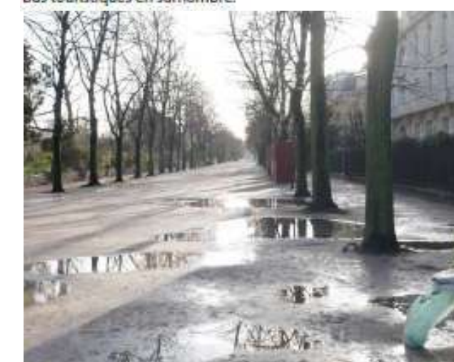
Stagnation d'eau due à l'imperméabilisation du sol par tassement.
