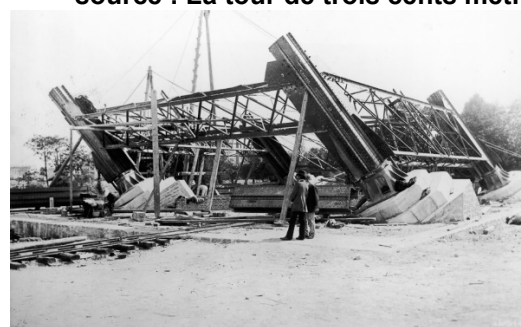
Un des piliers de la Tour Eiffel en construction (juillet 1887) – source : FPG/Hulton Archive/Getty Images
