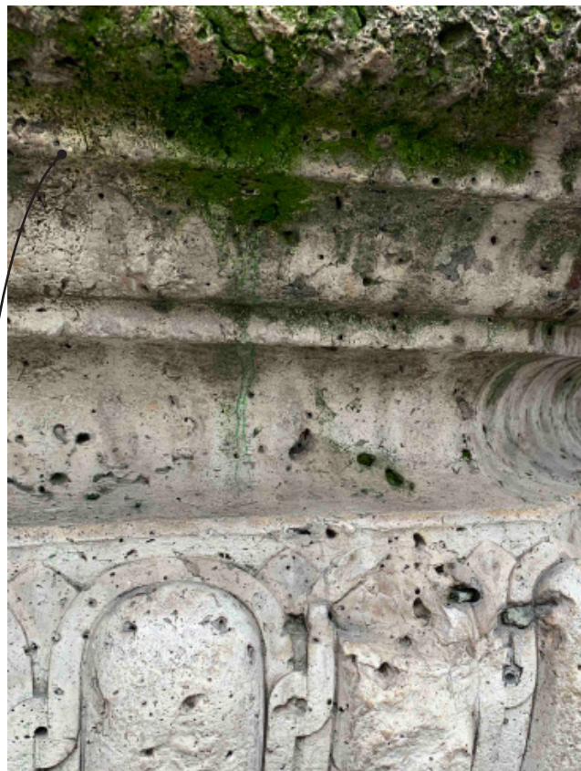
Partie inférieure de la vasque : lichen et algues vertes
