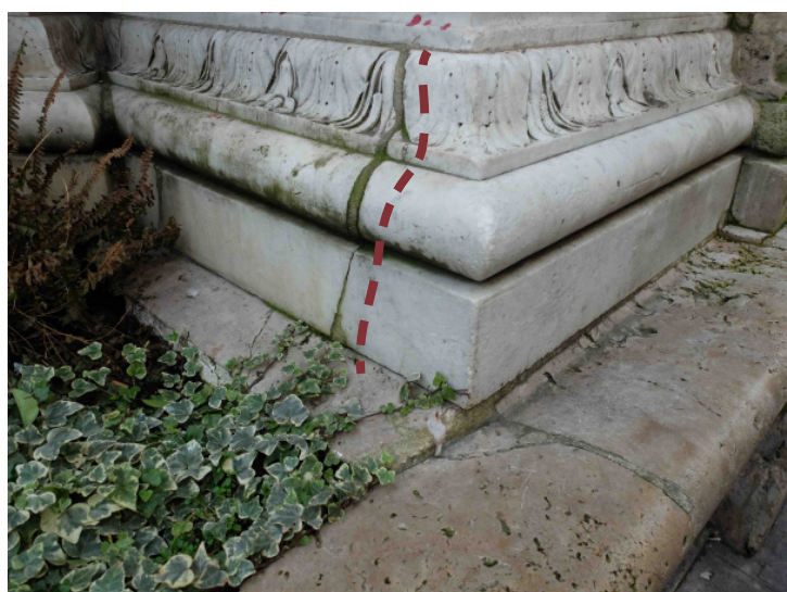
Marbre fissuré au niveau du soubassement occidental : les fissures ont déjà été remaillées. © Sunmetron
