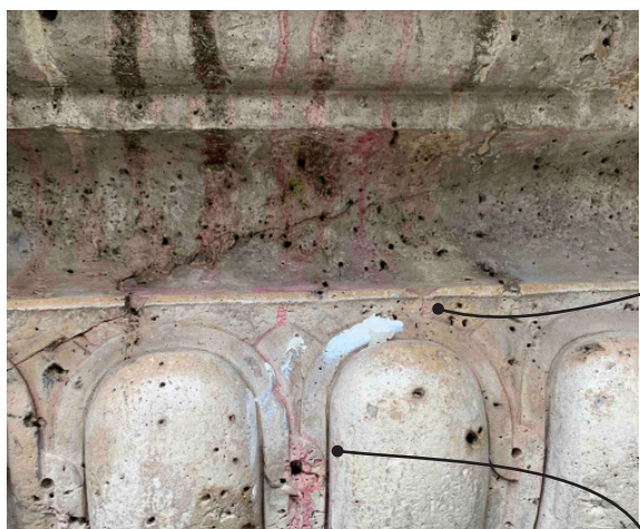
Partie inférieure de la vasque côté ouest. coulures rosées
