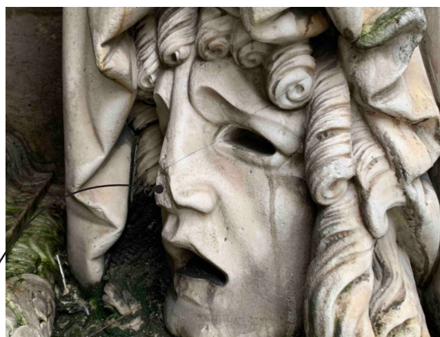
érosion de la pierre et des éléments sculptés (disparition de la liste chronologique sculptée)
