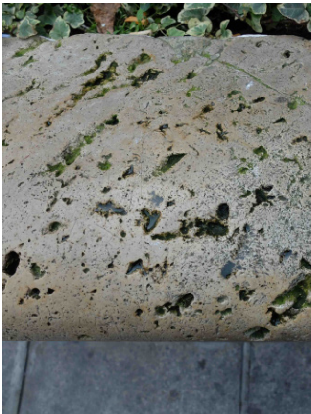
Partie supérieure de la margelle : stagnation de l'humidité et algues vertes
