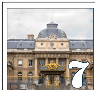
TRAVAUX EN COURS
