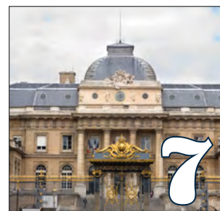
TRAVAUX EN COURS
