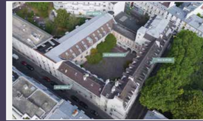
Vue aérienne et localisation des ailes (© Agence Wilmotte).
