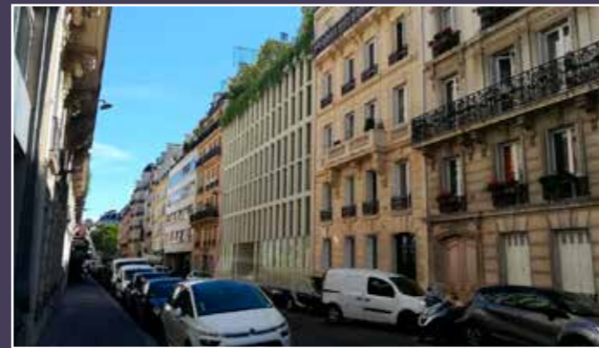
Vue d'insertion du premier projet, modifié pour répondre à l'avis du DHAAP (© 100° étage).
