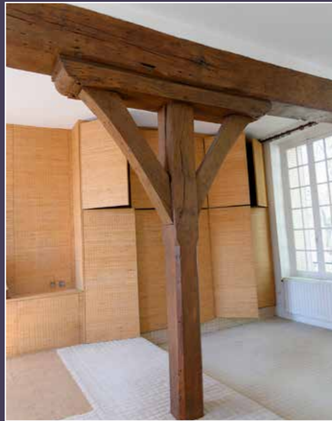
Renforcement des planchers dans l'aile Scipion.
