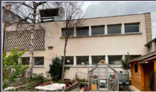
Vue actuelle de la façade arrière (© Annie François architecte).
