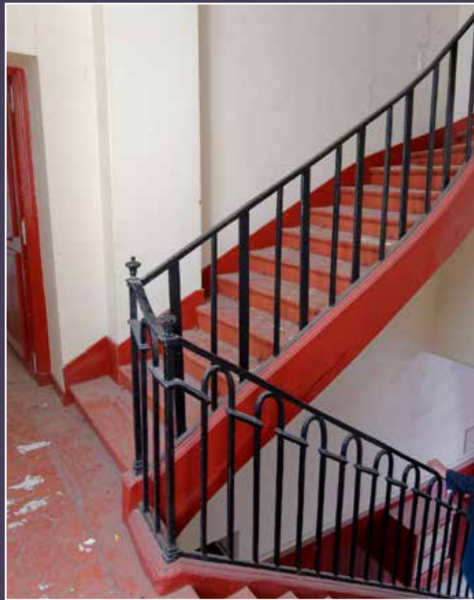
Premier palier de l'escalier à l'articulation des ailes Scipion et Vésale.
