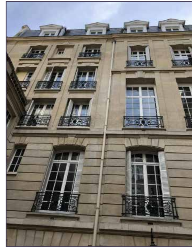
Vue actuelle de la façade sur cour.
