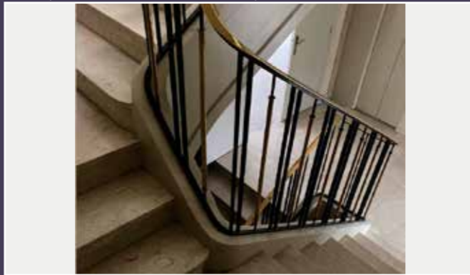
Vue actuelle de l'escalier principal (© Wilmotte & associés architectes).
