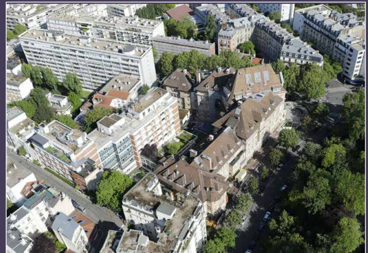
Vue aérienne du site, état existant (© Brunet-Saunier Architecture).
