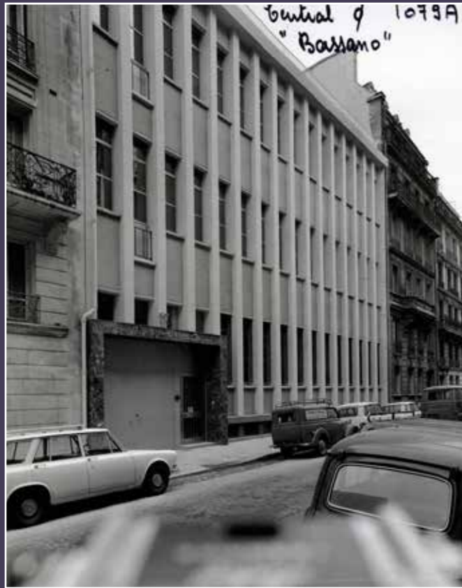
Vue de la façade sur la rue de Bassano en 1968 (© Archives Orange / DGCI).
