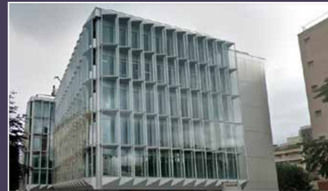
Vue actuelle d'une façade rénovée depuis l'angle des rues Renault et du Château-des-Rentiers.
