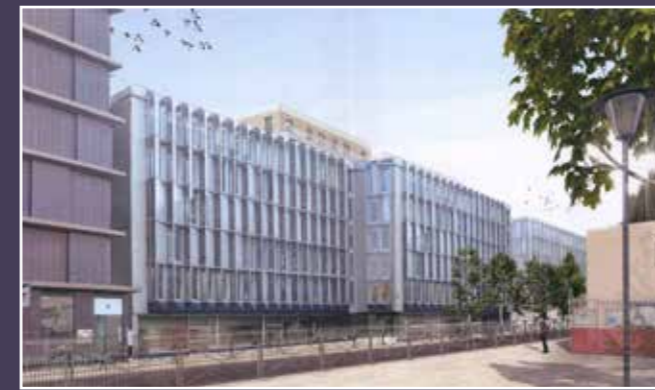
Vue des façades depuis la rue, état existant (© Jean Waniowski architecte).
