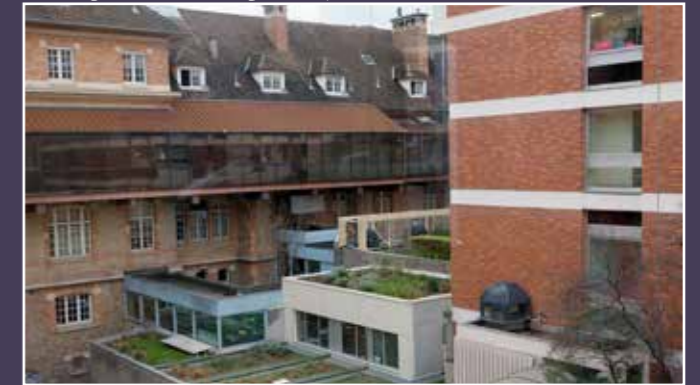
Vue actuelle de l'espace extérieur.
