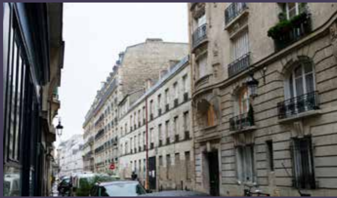
Vue actuelle de la façade du grand corps de logis depuis la rue Oudinot (C).
