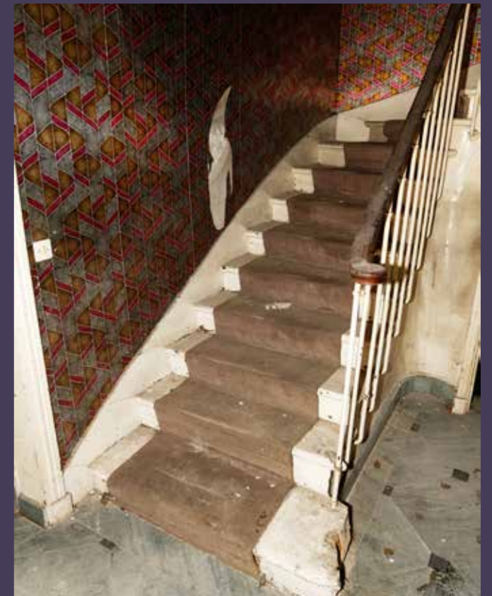
Vue actuelle de l'escalier de l'extension du corps de logis entre cour et jardin (E).
