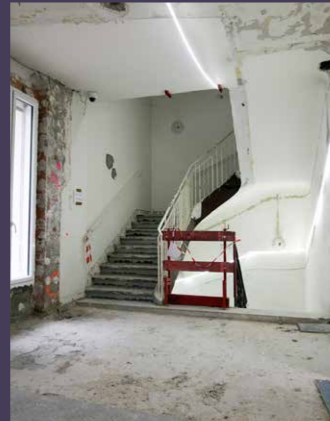
Vue actuelle de l'escalier.
