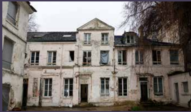
Vue actuelle du grand corps de logis entre cour et jardin (A).
