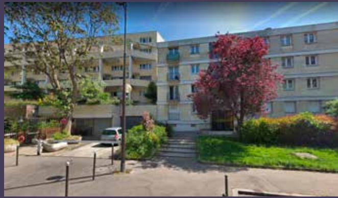
Vue actuelle prise rue Henri Duvernois d'une des barres d'habitation édifiées par Crevel et de l'immeuble construit par Thurnauer.
