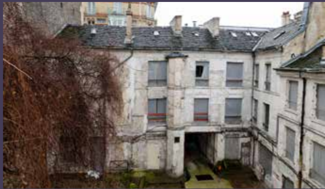
Vue actuelle de la façade sur cour du grand corps de logis (C).
