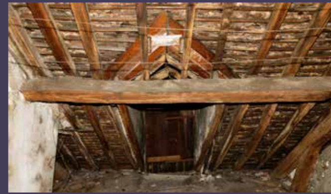
Vue actuelle de la charpente du grand corps de logis entre cour et jardin (A).
