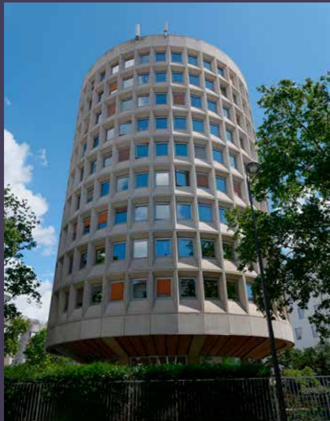
Vue actuelle de la tour depuis l'avenue.
