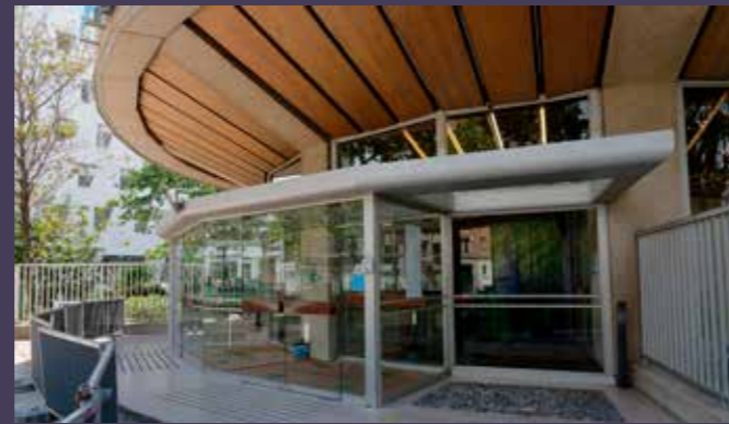
Vue actuelle du sas d'entrée.
