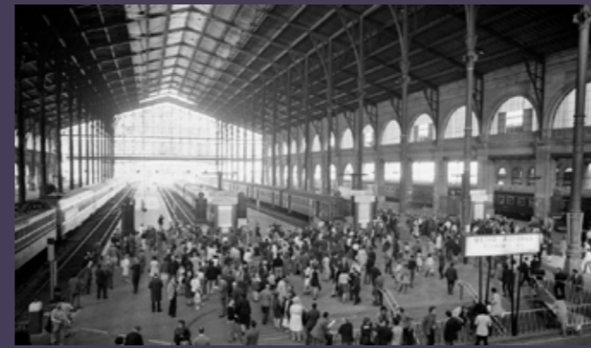
Vue de la halle centrale vers 1960 (© Jacques Cuinières/Roger-Viollet).
