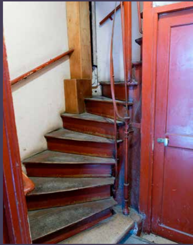
Vue actuelle d'un escalier.
