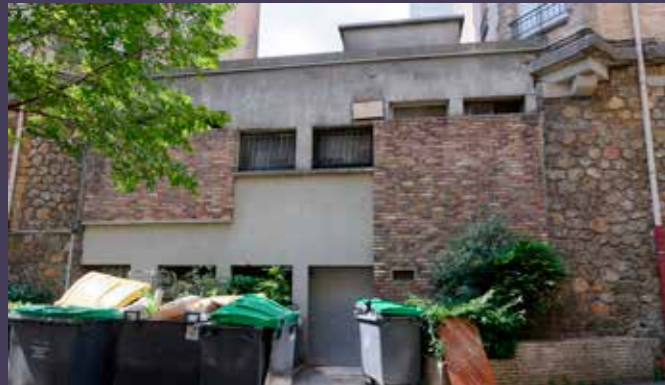
Vue actuelle du revers du bâtiment édifié le long de la rue de Ménilmontant pour fermer l'accès à la cité.
