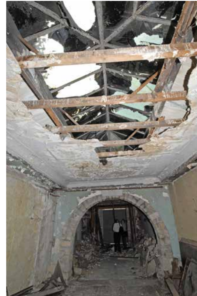
Vue actuelle de l'intérieur du bâtiment.
