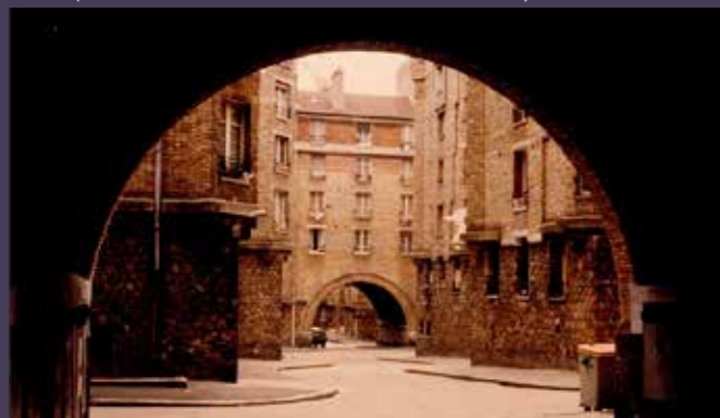
Perspective des deux arches avant la rénovation des années 1990 (© Paris Habitat).
