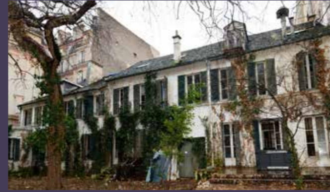
Vue actuelle de la façade sur jardin du grand corps de logis entre cour et jardin (A).
