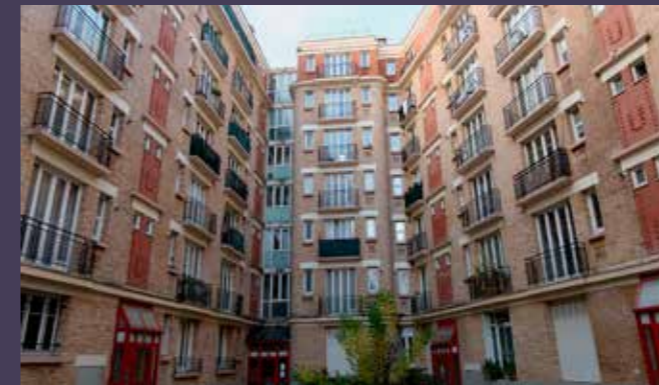
Vue actuelle des façades sur la cour.
