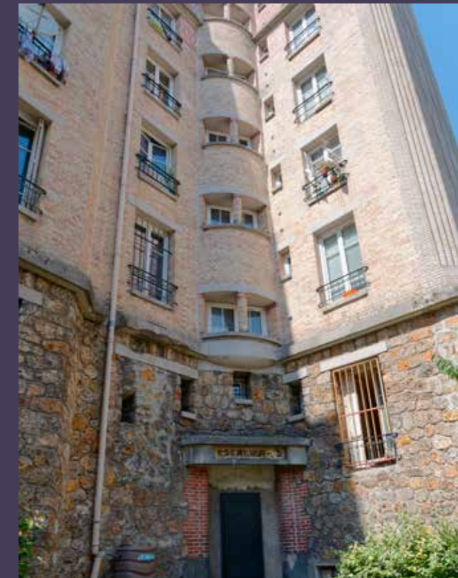
Vue d'une cage d'escalier supprimée dans les années 1990, sans que la façade en rez-de-chaussée n'ait été transformée.
