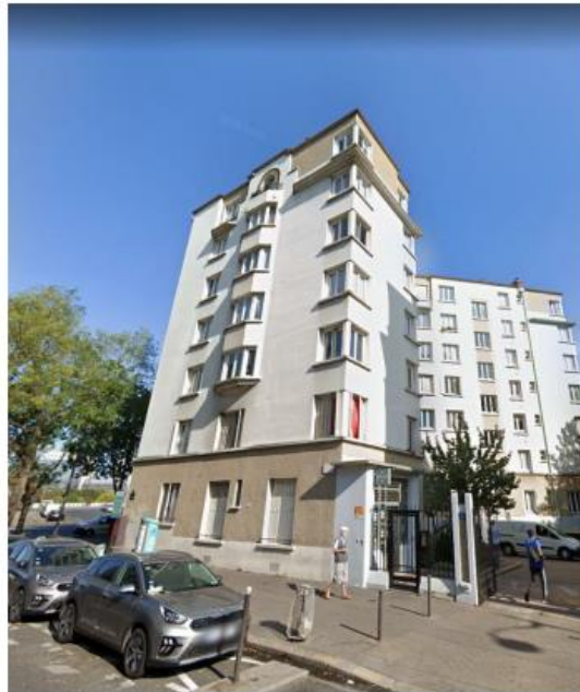
Photo du site vue depuis la rue avant travaux
