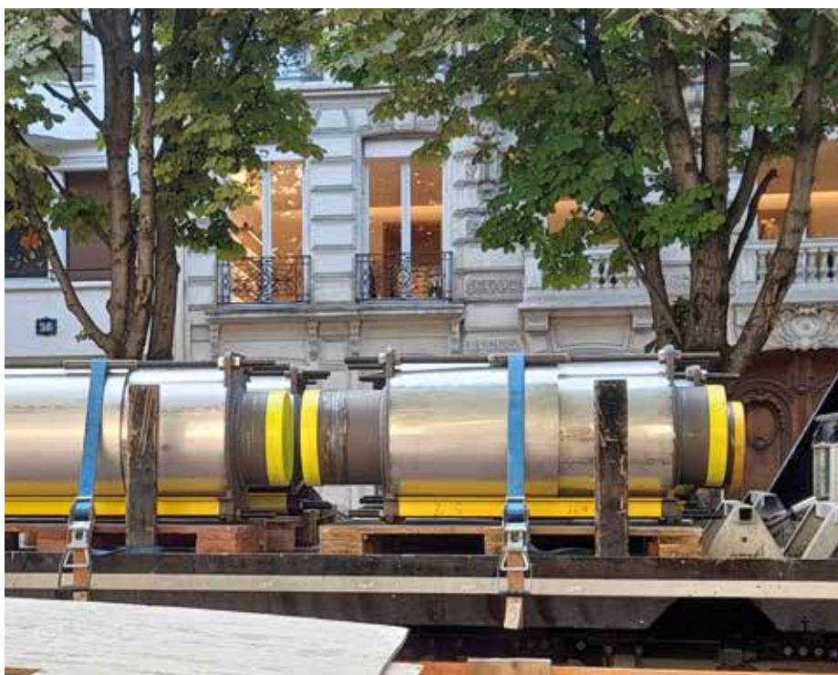
Des compensateurs avenue Montaigne 2021
