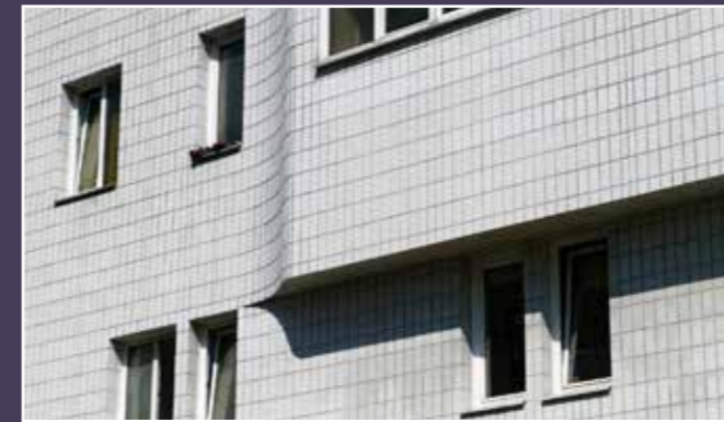
Détail de la façade.
