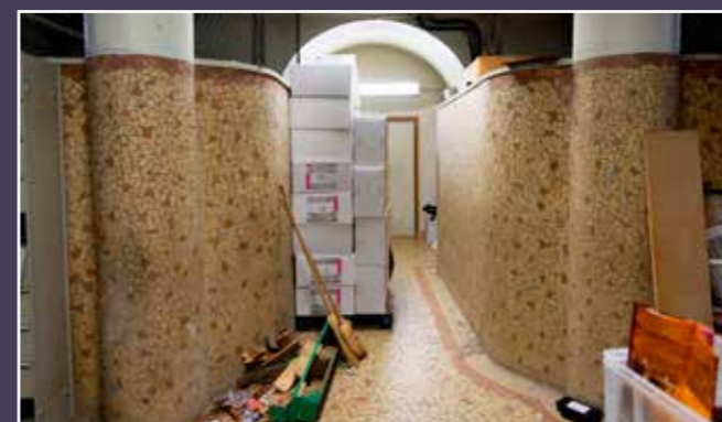
Vue actuelle de l'entrée de la salle des douches.
