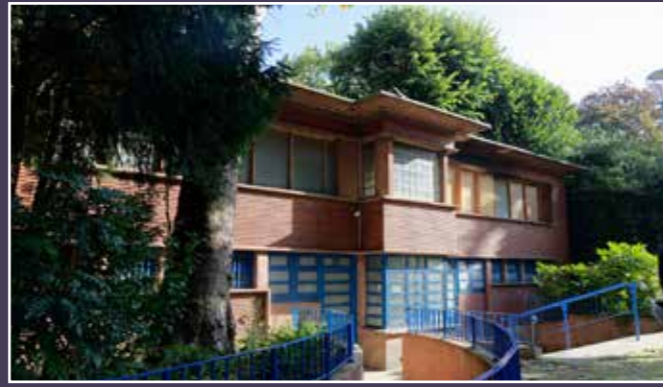
Vue arrière de l'abri de l'Aire de Jeu.
