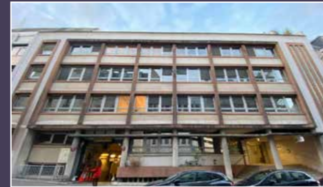
Vue actuelle de la façade sur rue du 13-17, rue Salneuve (© DTACC architectes).
