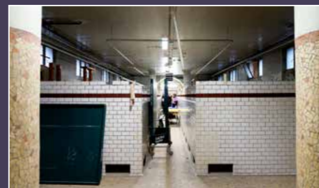
Vue actuelle du couloir central de surveillance.
