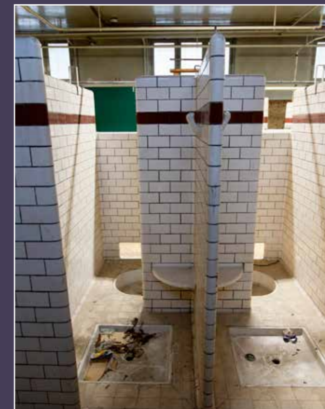
Vue actuelle de deux cabines de douches.
