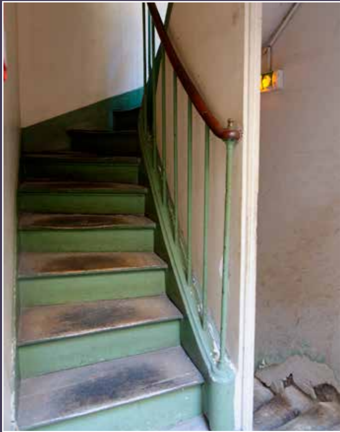
Vue actuelle du départ de l'escalier (B) datant du début du XIX e siècle.
