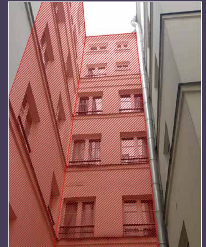
Vue actuelle du revers de l'immeuble avec indication en rouge des façades à démolir.
