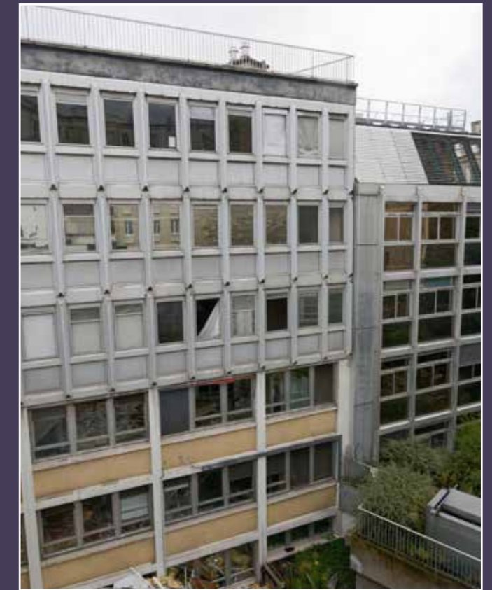
Vue actuelle de la façade arrière du 13-17, rue Salneuve présentant les trois étages de surélévation construits en 1970.
