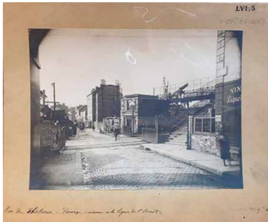
16. La rue du Château, son passage à niveau et sa passerelle, s.d., vers 1880 (© Godefroy / BHVP).
