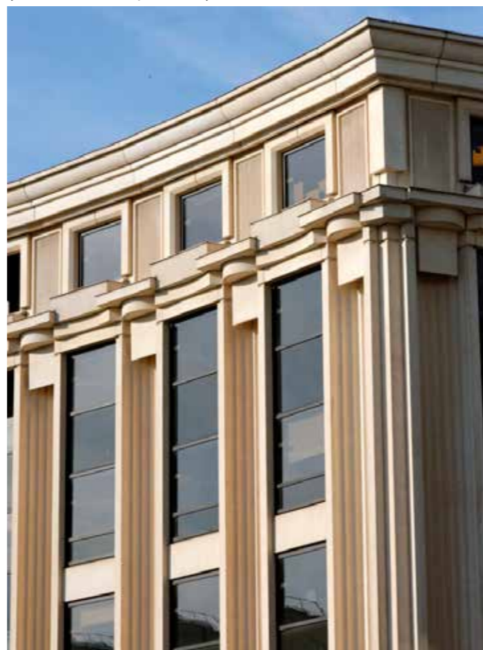
12. Détail d'architecture d'un des bâtiments de Novarina (© Marc Lelièvre / DHAAP).
