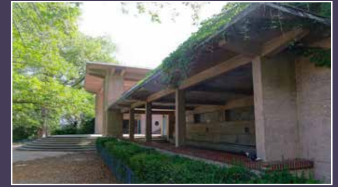
Vue de l'aile gauche de l'abri de l'Aire de Jeu.
