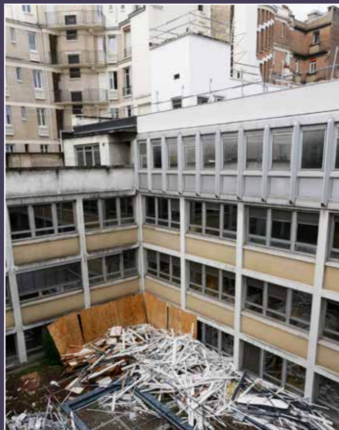
Vue actuelle de l'aile en fond de parcelle et de la surélévation de 1970 qui a absorbé un 3 e étage partiel.
