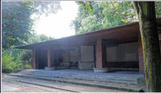
Vue avant de l'abri du Belvédère.
