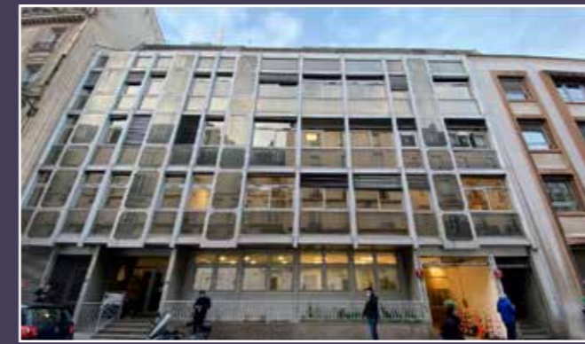
Vue actuelle de la façade sur rue du 9-11, rue Salneuve (© DTACC architectes).
