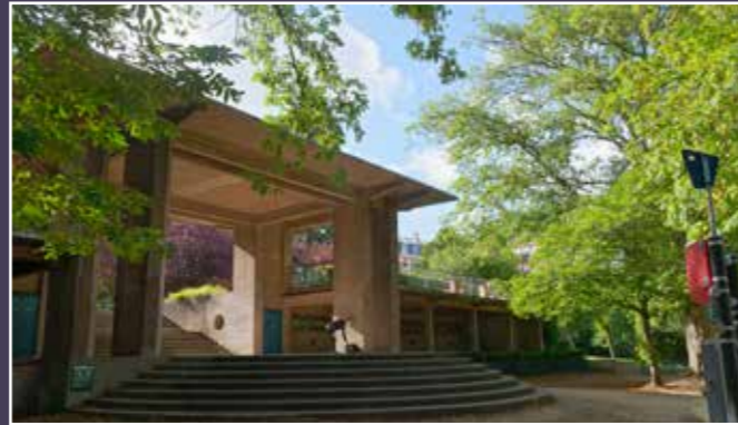
Vue du porche monumental de l'abri de l'Aire de Jeu.
