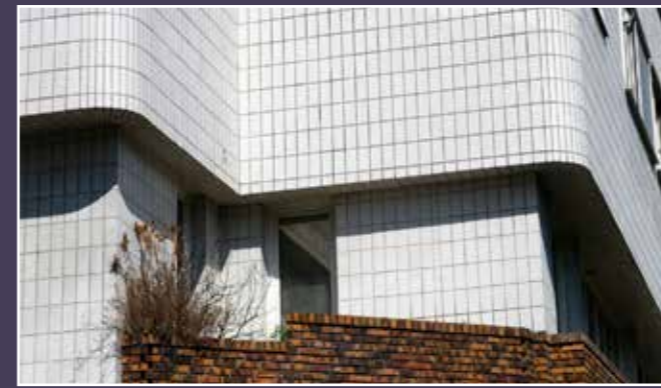
Détail de la façade.
