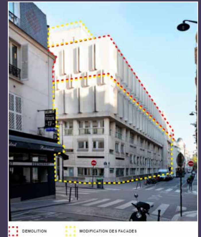
Vue actuelle présentant la zone de démolition du niveau supérieur du socle et celle de la dépose des façades (© DATA / OBVIE architectes).
