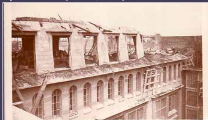
Photographie de l'incendie du 23-27 rue Guyot, 29 mars 1931 (Source : Internet).
