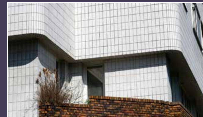
Détail de la façade.
