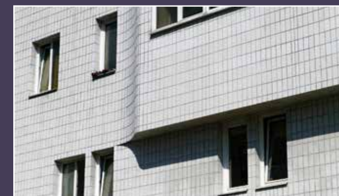
Détail de la façade.
