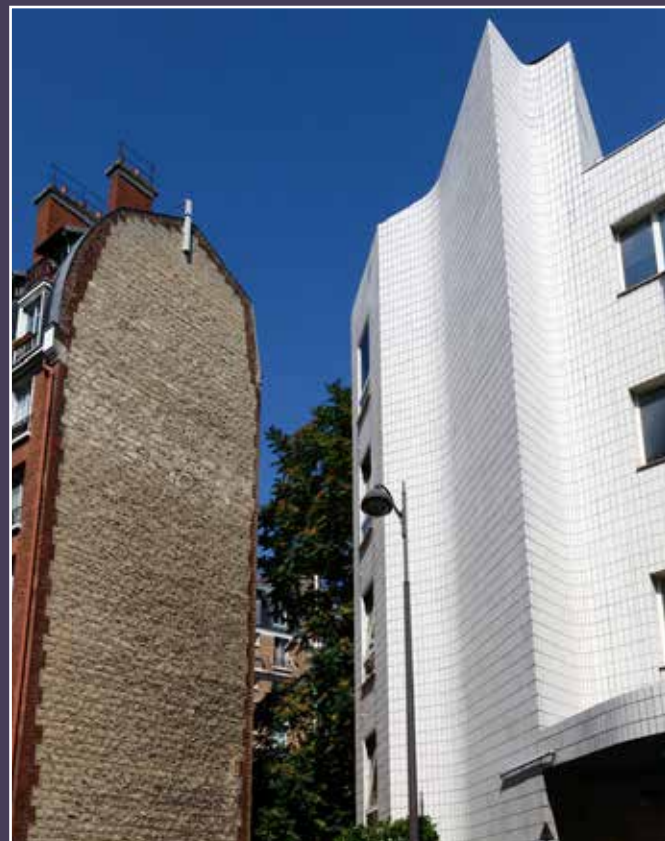
Tour des circulations verticales.
