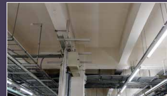
Vue actuelle de la structure du bâtiment.
