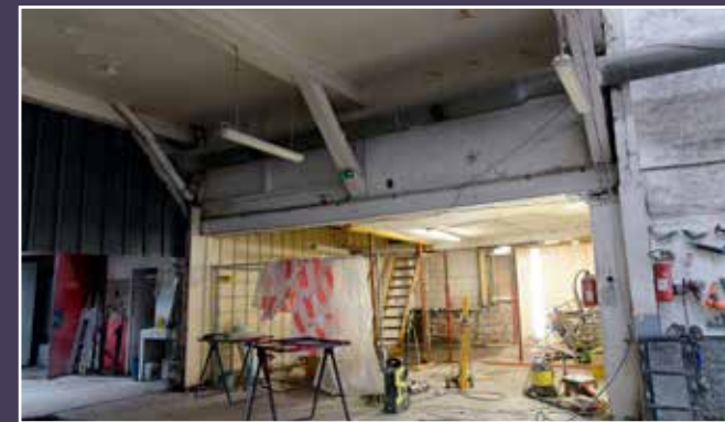
Accès à l'atelier depuis le garage sis au 42, rue des Poissonniers.
