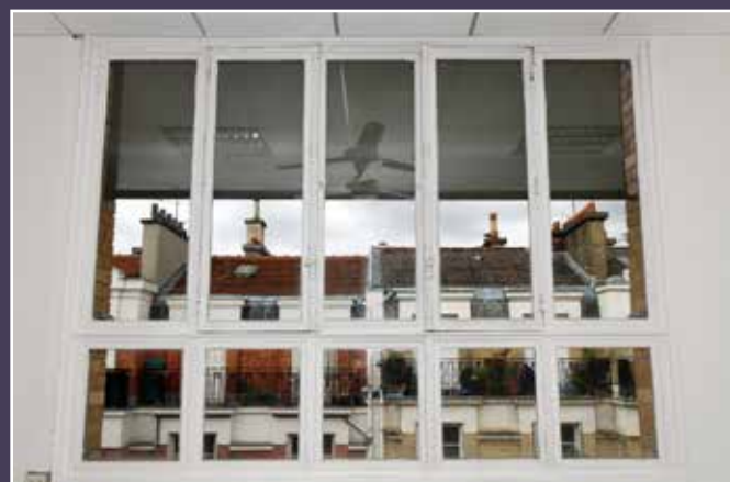
Menuiseries anciennes subsistant en façade arrière.
