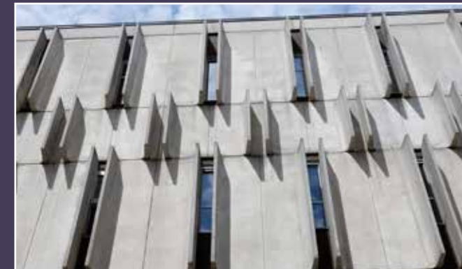
Détail des ouvertures de la façade principale.
