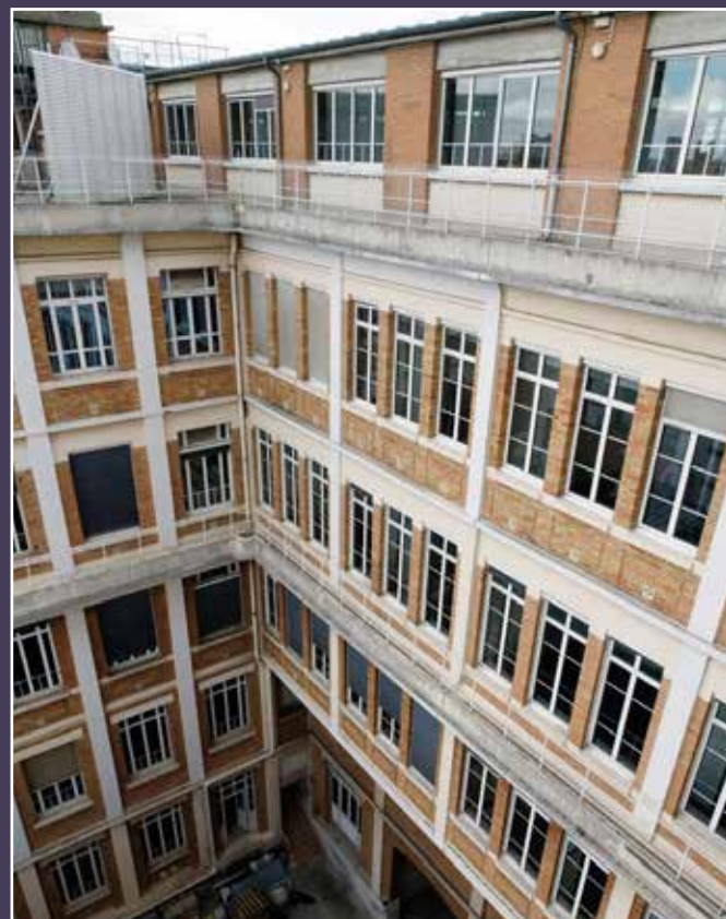
Vue actuelle des façades sur cour.
