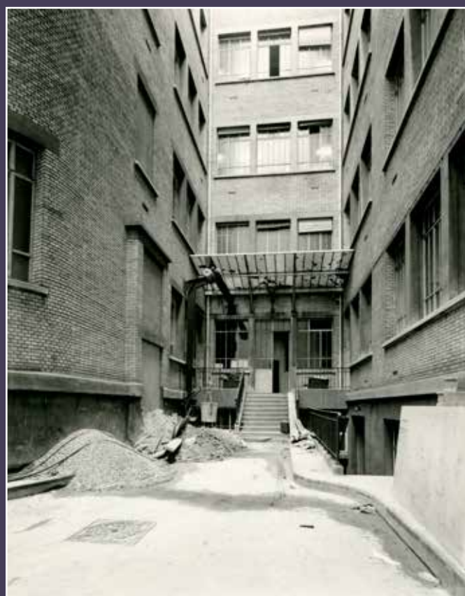
Réfection du sol à la jonction des deux ailes du bâtiment d'origine (© Orange / DANP).
