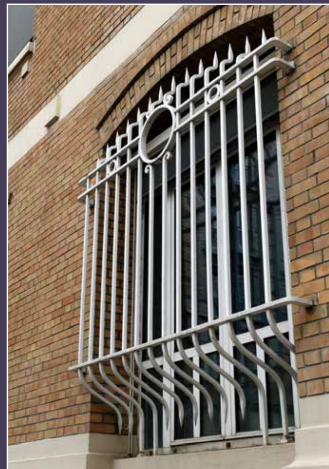
Grille de défense du rez-de-chaussée haut sur la rue Jobbé Duval.
