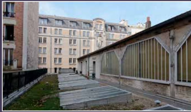
Vue des baies des ateliers depuis la terrasse du rez-de-chaussée.
