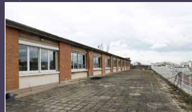
Vue actuelle de la surélévation bâtie sur la terrasse.
