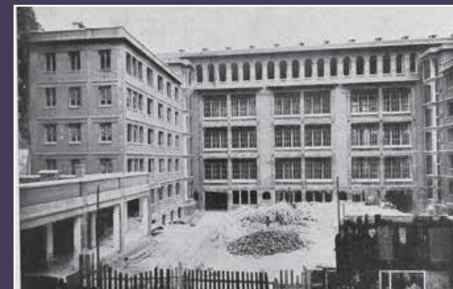
Vue du central téléphonique achevé (publiée dans L'Architecte , 1925).
