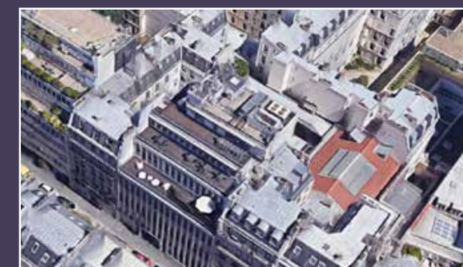
Vue aérienne de la parcelle (Source : Internet).
