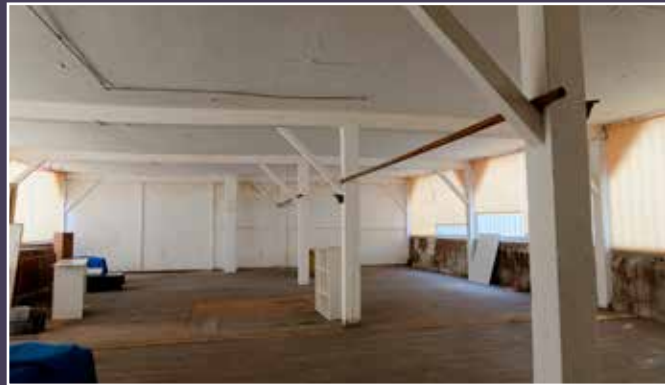
Vue des ateliers du premier étage.
