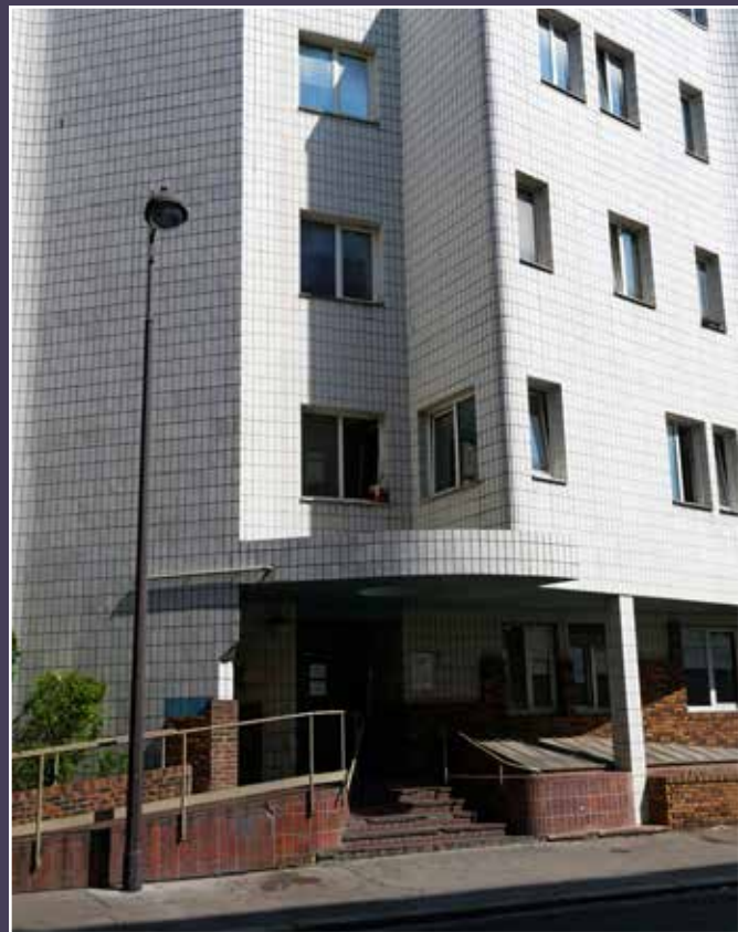
Vue de la façade au 5, rue Bessin.
