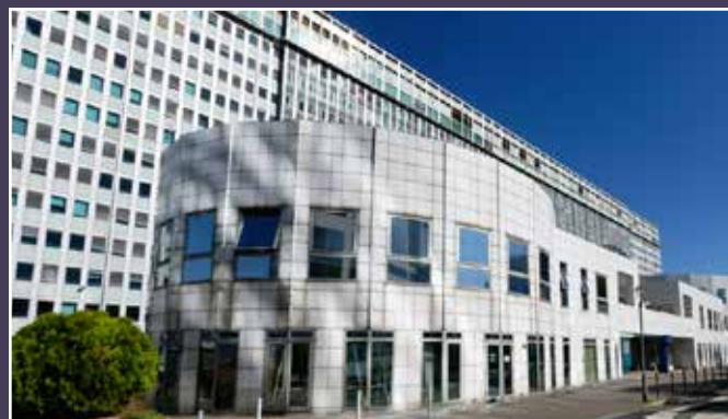
Vue actuelle de la façade principale du bâtiment nord.
