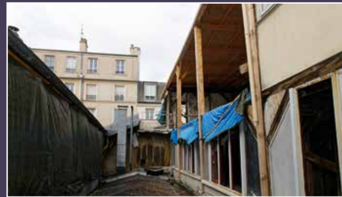
Vue des deux ailes en ateliers du n° 16.
