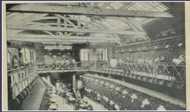
Vue intérieure de l'ancien central téléphonique, 29 rue des Renaudes (© BHVP).
