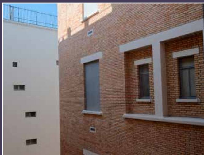
Vue actuelle des façades sur cour (détail).
