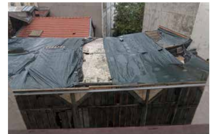
Vue actuelle de la couverture de l'atelier.
