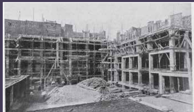
Vue du central téléphonique en construction (publiée dans L'Architecte , 1925).
