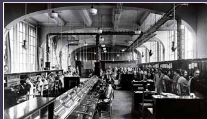
Grande salle des opératrices du centre téléphonique automatique au second étage, 1928 (© Orange / DANP).
