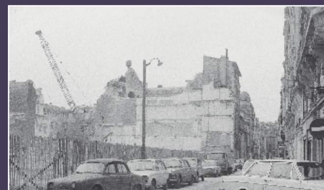
Vue en 1971 de l'angle des rues Poncelet et des Renaudes en cours de démolition. Au fond, l'ancien central Wagram (Casier archéologique).
