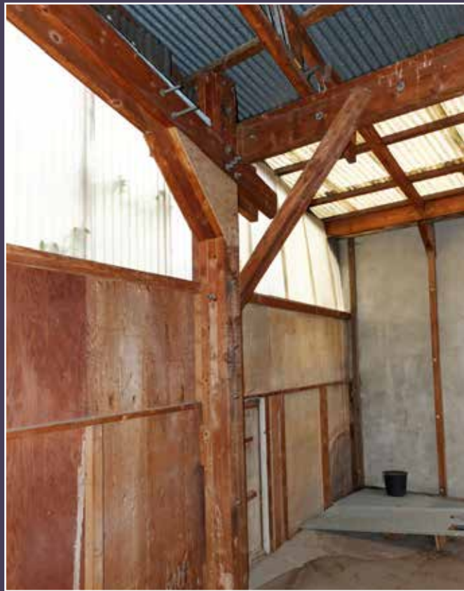
Vue de la structure mixte de l'atelier, à l'arrière du n° 14.
