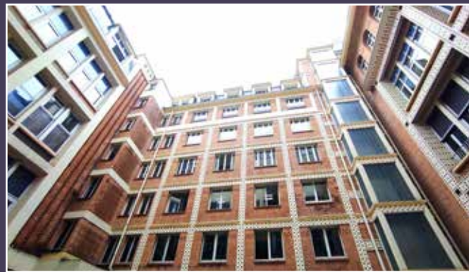
Vue actuelle des façades sur cour.
