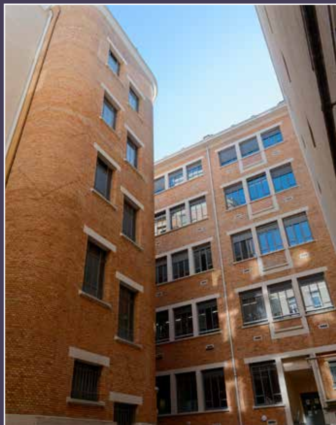
Vue actuelle des façades sur cour
