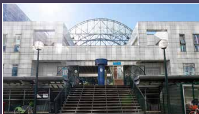
Vue actuelle de la façade arrière du bâtiment nord.
