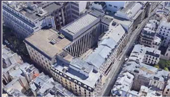
Vue aérienne du bâtiment « Pastourelle ».
