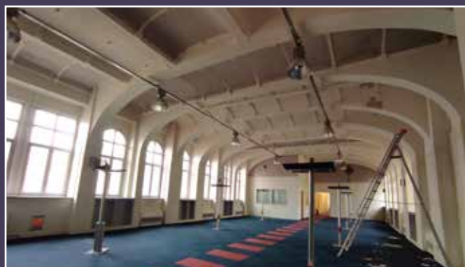
Vue d'un étage courant du bâtiment de fond de cour.
