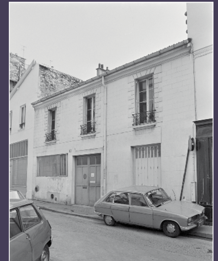
Vue de la façade sur rue du n° 14 en 1982 (Casier archéologique).
