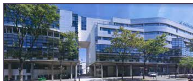
Vue actuelle du bâtiment (© Engelmann Architecte).
