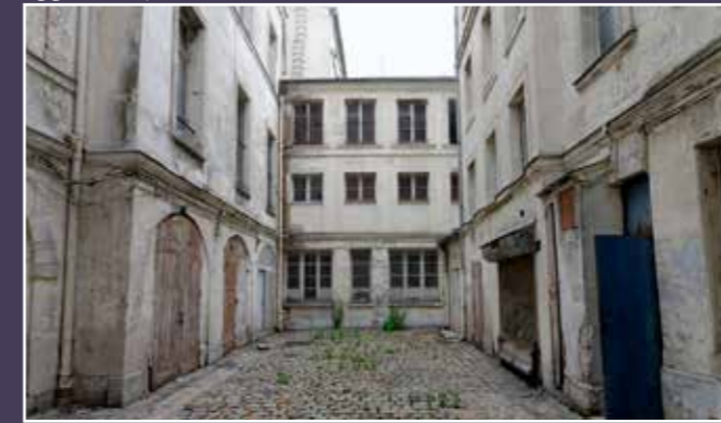
Vue actuelle du bâtiment en fond de cour.
