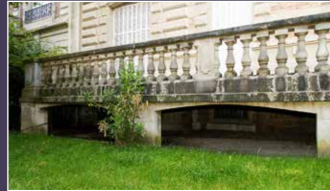
Vue de la terrasse dans son état actuel.
