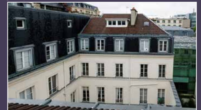
Vue actuelle sur la cour, vers le sud.
