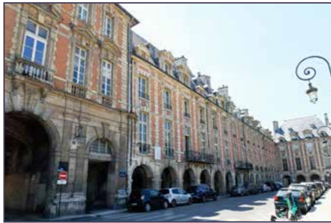
Vue actuelle du bâtiment depuis la place des Vosges.
