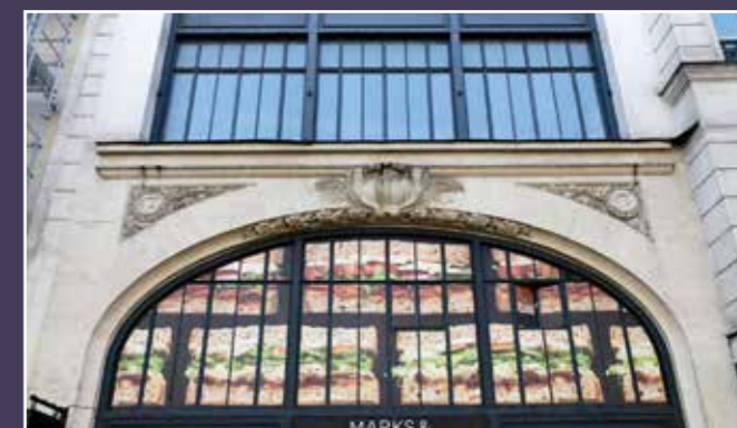
Détail de la façade actuelle.
