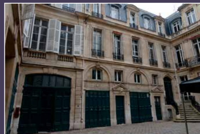
Vue de l'aile nord sur cour.
