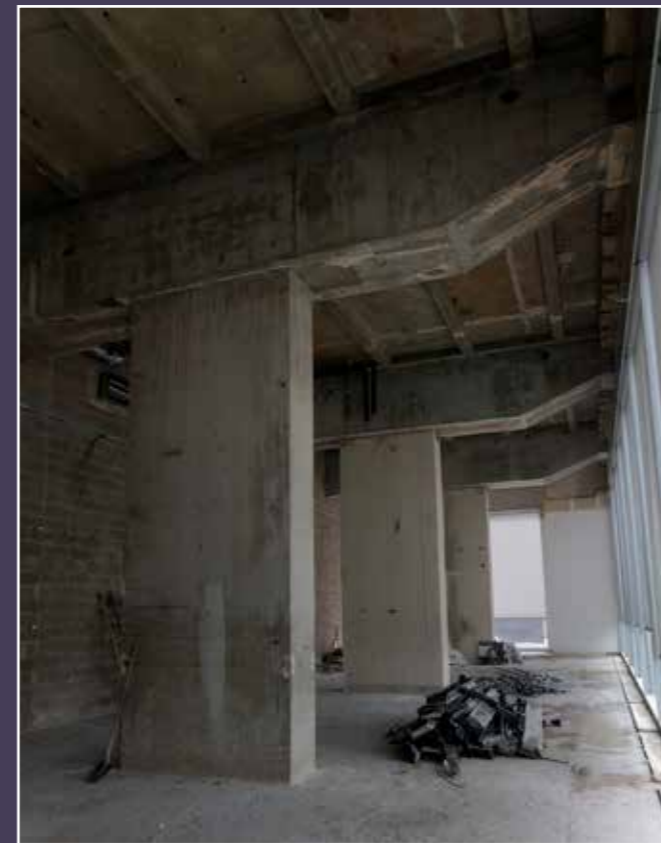
Vue actuelle des superstructures du rez-de-chaussée.
