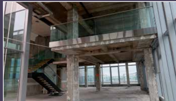
Vue du dernier étage dont le plancher a été partiellement démolé en 2006, photographié en 2021 lors du curage.
