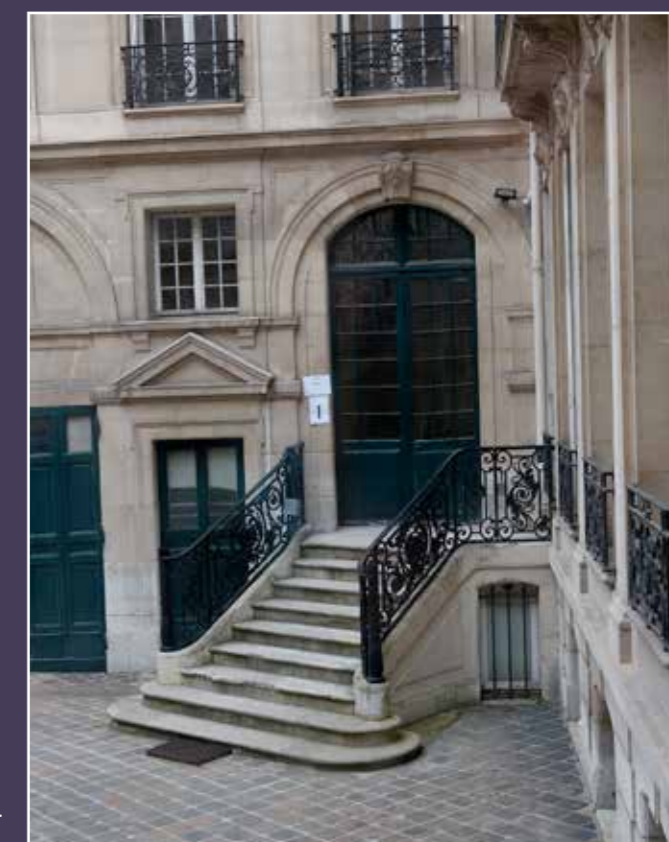
Vue du perron de l'angle nord-est.
