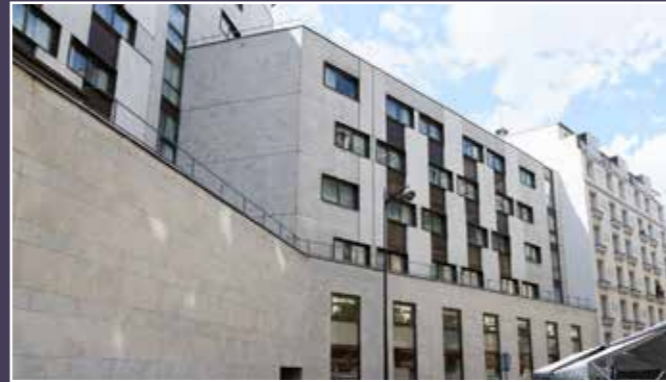
Vue actuelle de la jonction entre le Méridien et les immeubles de rapport de la rue Waldeck Rousseau.
