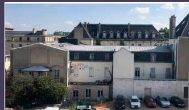
Vue des pignons dans la cour Jalaguier (© Atelier Monchecourt & Co).
