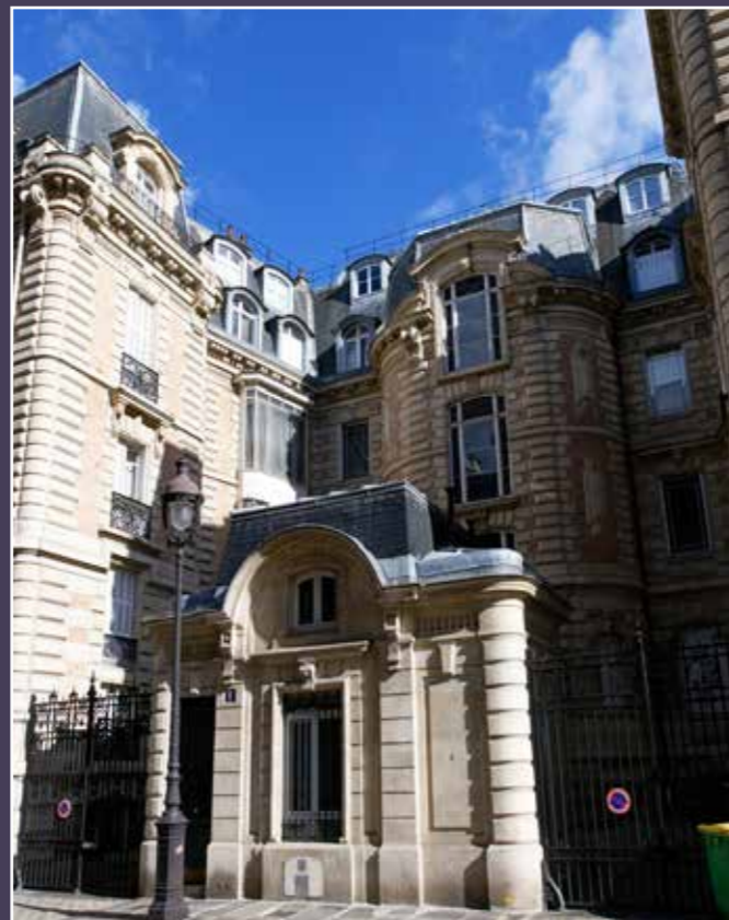
Vue de la cour et de la loge du gardien au 8, rue Murillo.
