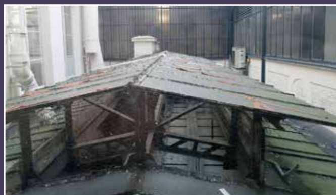
Détail de la verrière de la cour.
