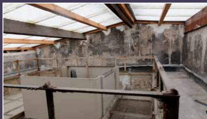
Vue de l'ancienne verrière éclairant l'escalier percée par la machinerie de l'ascenseur installé au début du XX e siècle.
