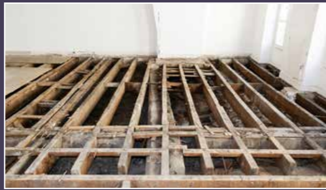
Vue des sondages réalisés au R+2.
