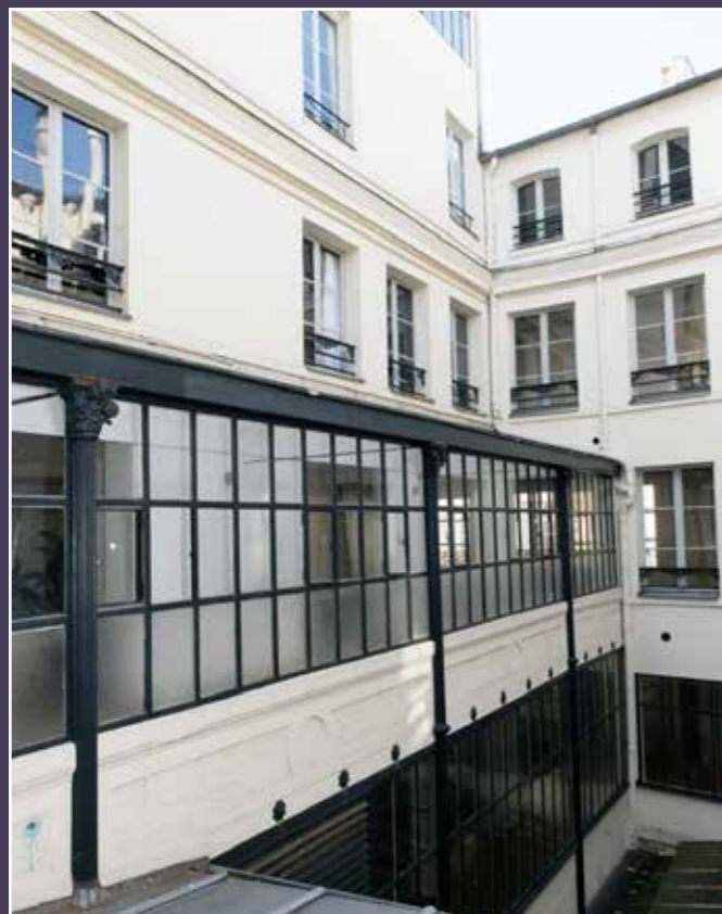
Vue de la galerie vitrée.
