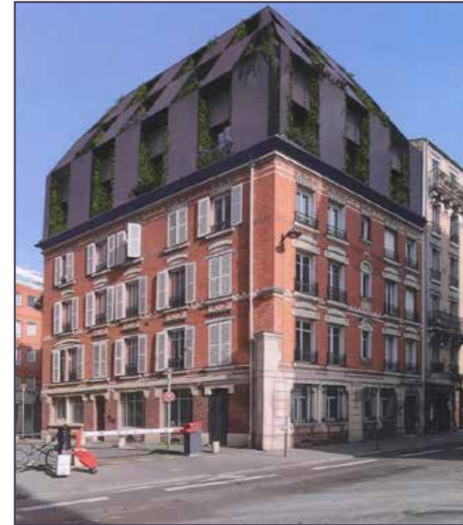
Vue projetée du bâtiment (© Atelier Julien Sécheresse Architecte).
