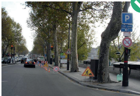
Pour tout arrêt minute, le véhicule doit être protégé par des cônes.
