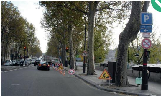
Pour les chantiers mobiles ou de courte durée mais également pour le stationnement de véhicule(s) sur la chaussée ne dépassant pas 4 heures, la signalisation réglementaire temporaire peut être posée au sol (ici voie limitée à 50km/h).
