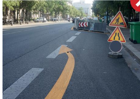
Le support de la signalisation temporaire doit être scellé au sol ou fixé sur un mobilier existant
