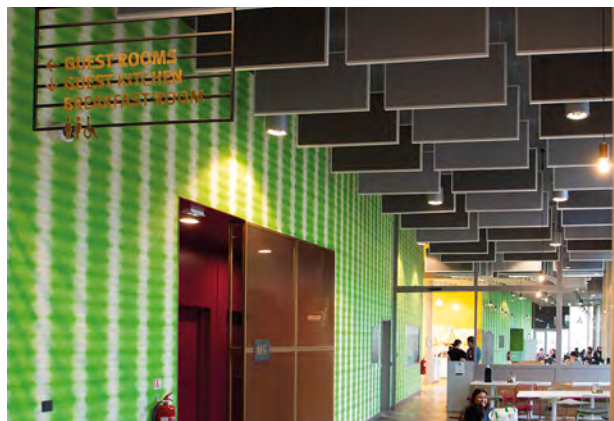
Dispositif anti bruit dans un immeuble (12 e ) © Christophe Jacquet / Ville de Paris
