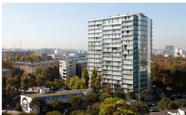
La rénovation énergétique de la Tour Bois-le-Prêtre (17 e ) © David Boureau / Apur
