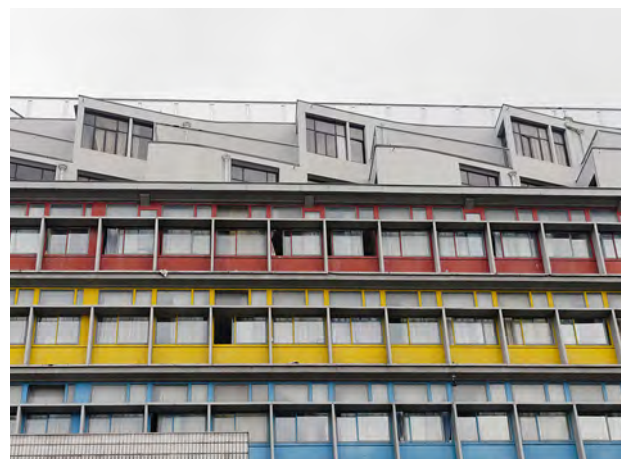
La Cité de refuge rue Cantagrel (15 e ) © Saussereau / Ville de Paris
