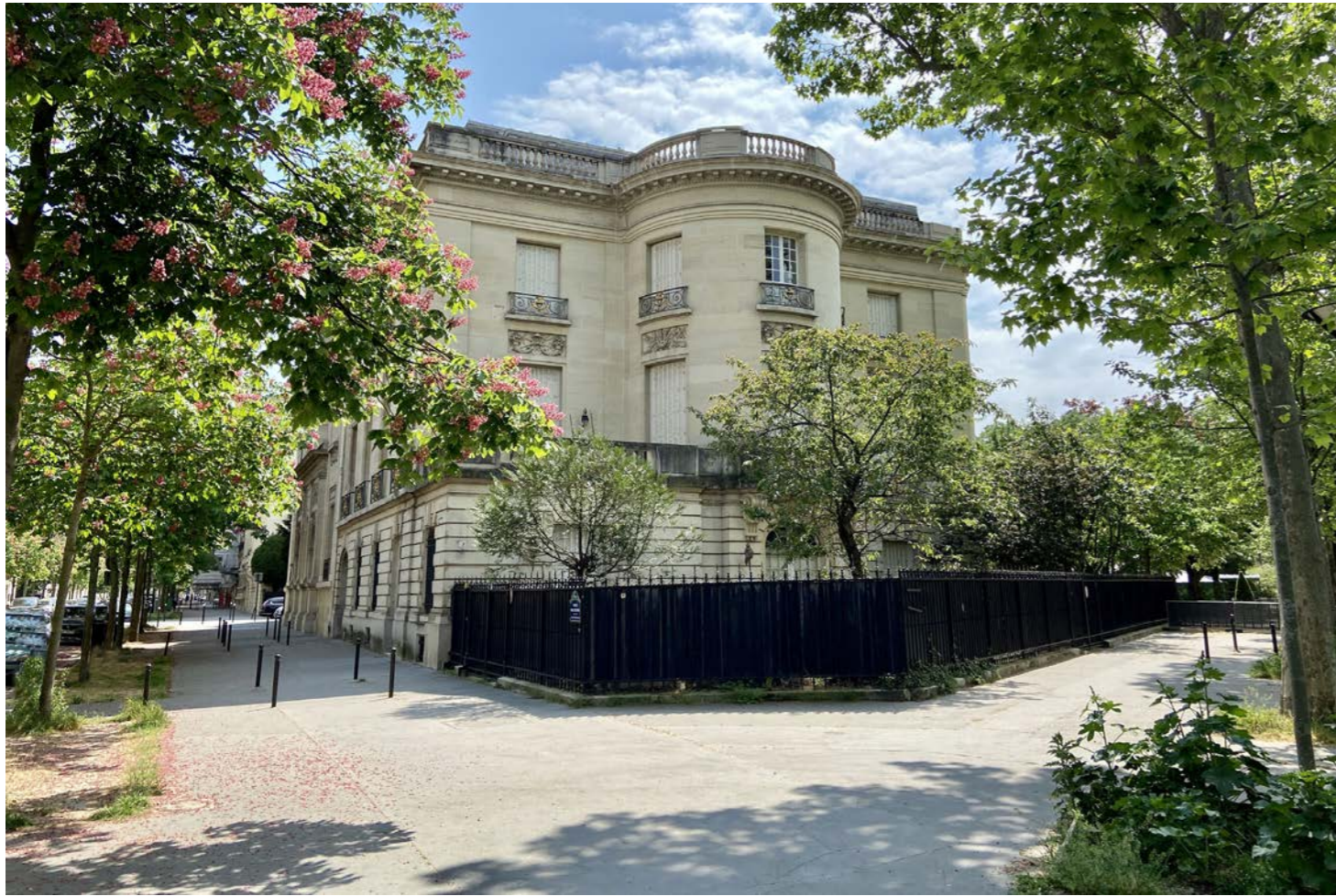
ÉTAT EXISTANT_VUE SUR L'HÔTEL PARTICULIER VERS L'AVENUE EMILE DESCHANEL
