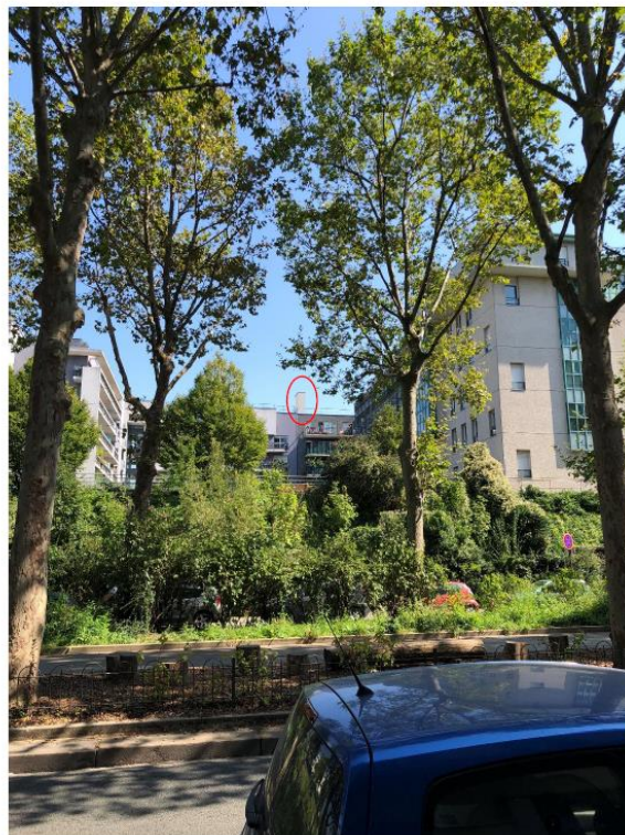
Prise de vue n°1 après travaux
