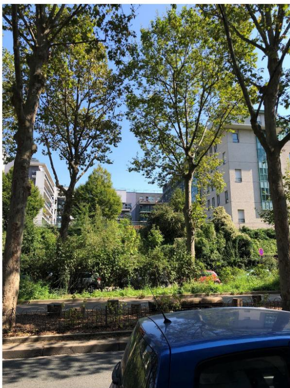
Prise de vue n°1 avant travaux
