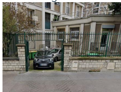
Accès parking Extérieur gardien
