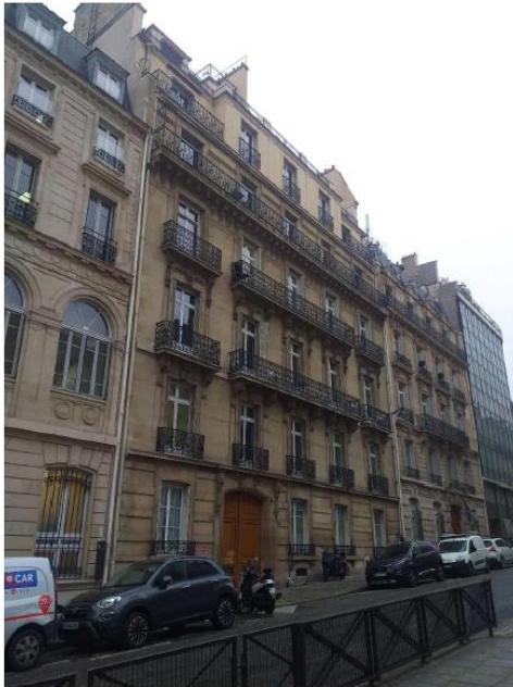
Photo du site vue depuis la rue avant travaux
