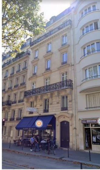
Photo du site vue depuis la rue après travaux
