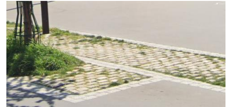
Exemple de pavé enherbé rue du Chevaleret
