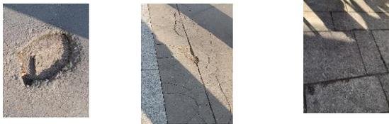
Dégradation du sol rebouchage à prévoir, sol fissuré, risque potentiel de chutes
