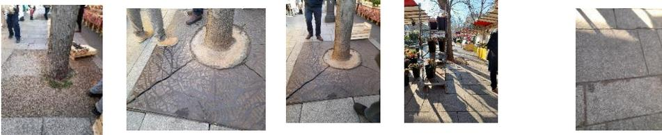
Contour pied d'arbre avec trou - grille contour pied d'arbre descellée, dallage défectueux
