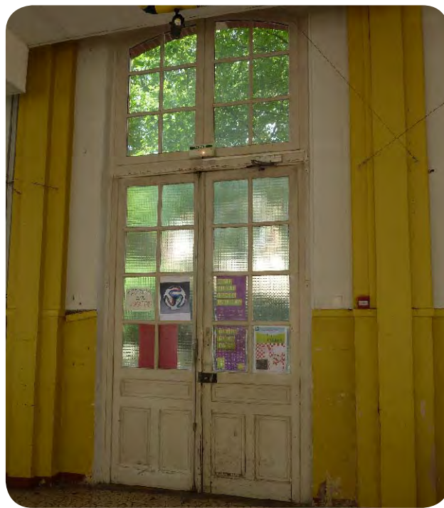
Porte d'école avant travaux de rénovation
