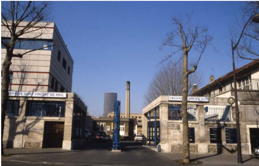
La tour Montparnasse dans l'axe de l'entrée de l'hôpital
