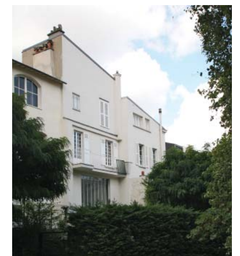
Façades arrières des 39, 41 et 43 rue Boissonade
