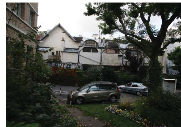
Les ateliers du 45-49 rue Boissonade
