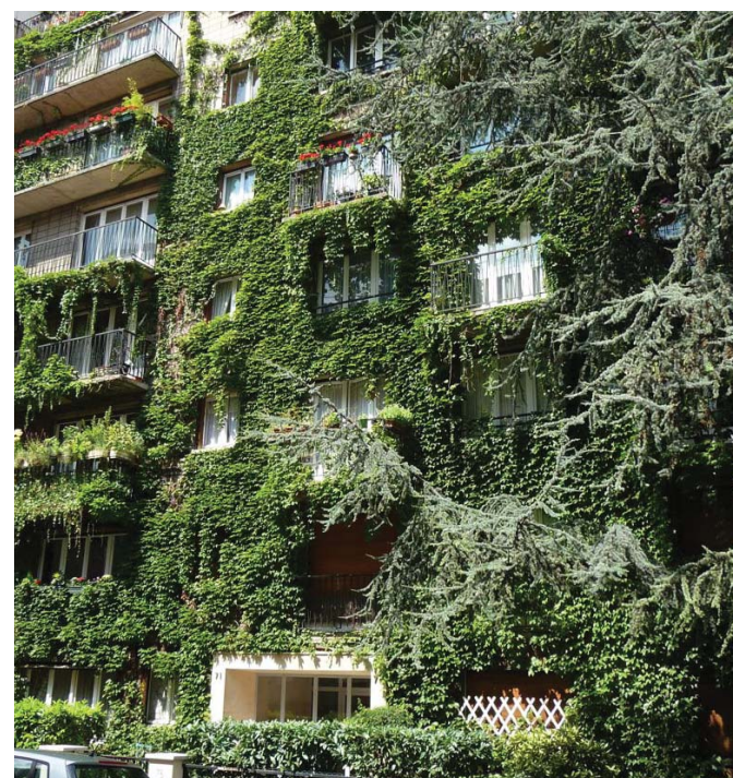
Façade au 71 de la rue de la Colonie Paris 13°
