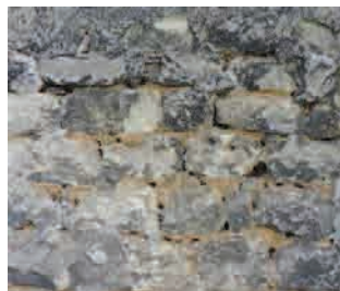
Figure 103 : trous d'hyménoptères dans le mur de la Fondation Cartier
