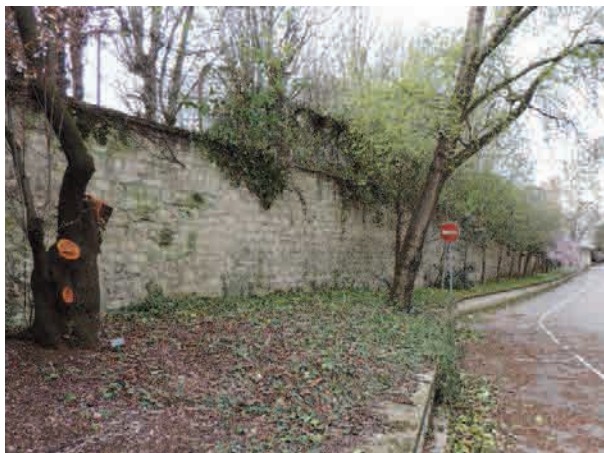
Figure 76 : le mur en pierre séparant le site étudié et les jardins des sœurs de la Visitation
