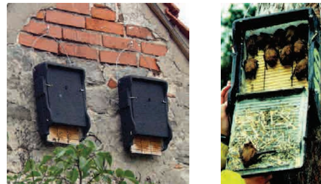
Figure 129 : exemple d'un gîte de façade de tye « Schwegler »
