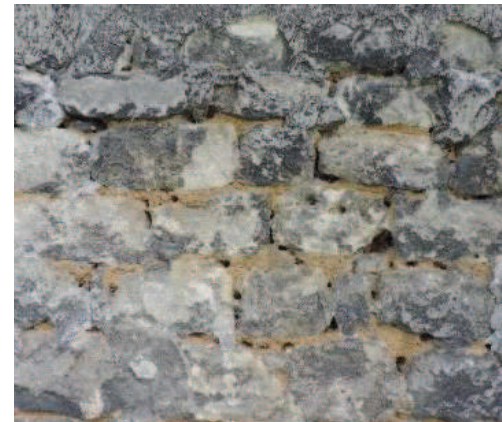
Figure 122 : Photos d'un pan de mur à la maçonnerie dégradée dans les jardins de la Fondation Cartier
