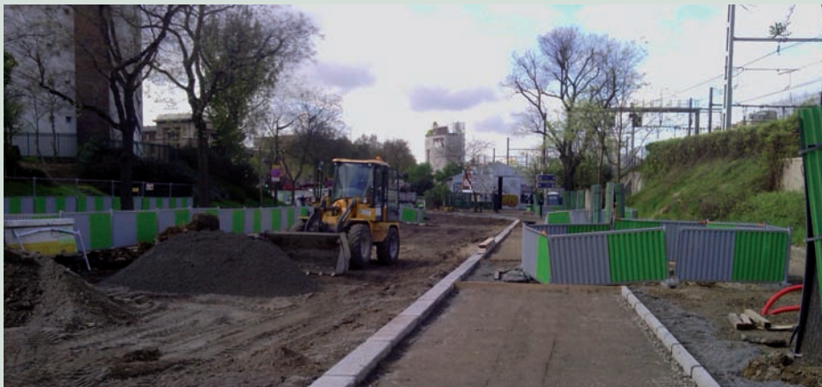
Travaux de voirie rue Julia Bartet
