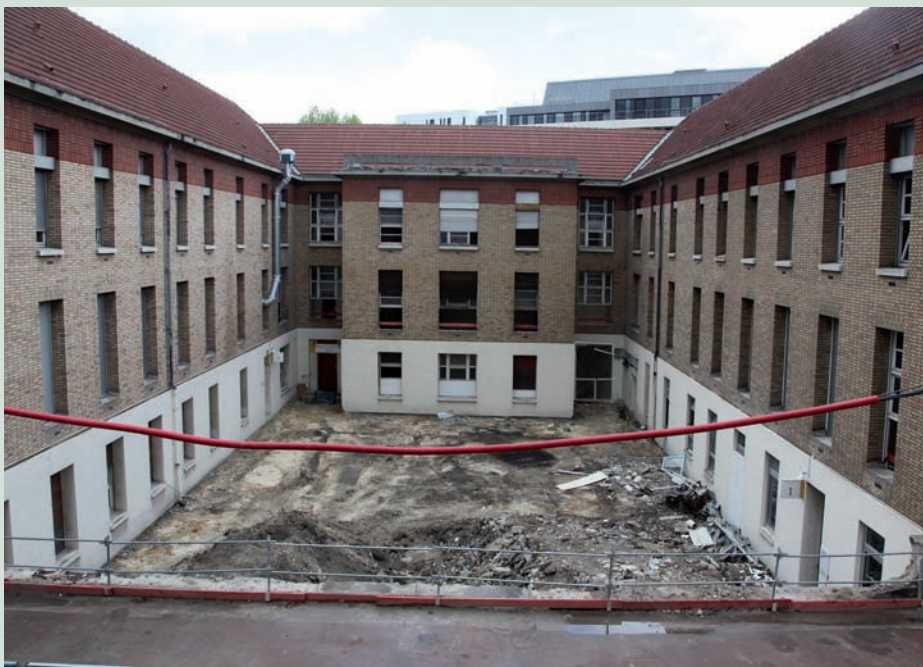
Chantier de réalisation de l'EHPAD (phase de démolition partielle)
