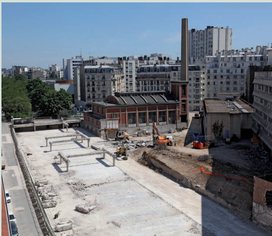
Broussais - démolition du parking
