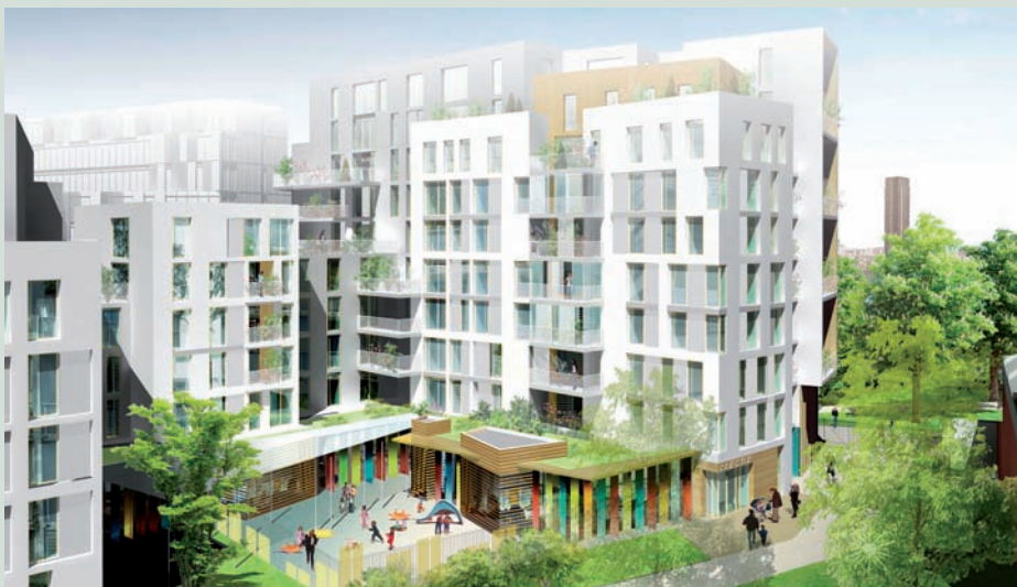
105 logements sociaux, une crèche et un centre social
