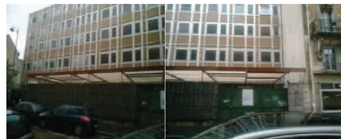
Entrée condamnée rue Boissonade (Source : Mediaterrre Conseil Décembre-2014)
