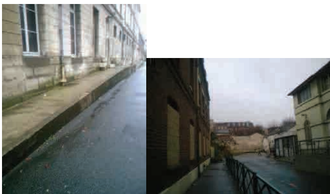
Accès rampe handicapées bâtiment de l'Oratoire et barrières de sécurité bâtiment Pierre Robin (Source : Mediaterrre Conseil-Décembre-2014)
